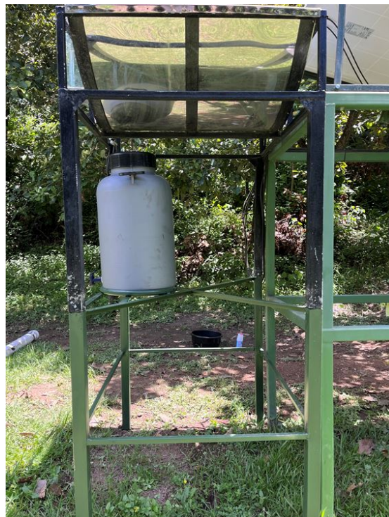
Figura 80: Estructura extra para soporte del módulo 2 y tanque 3.
