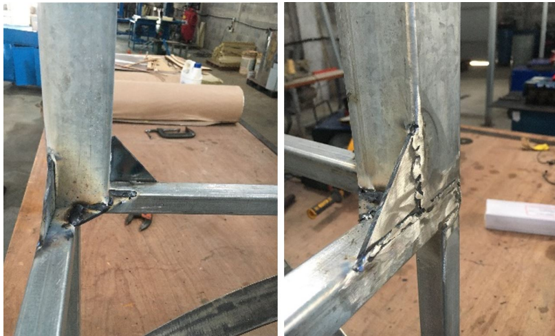
Figura 60: Soldaduras de refuerzo en estructura del módulo 2.
