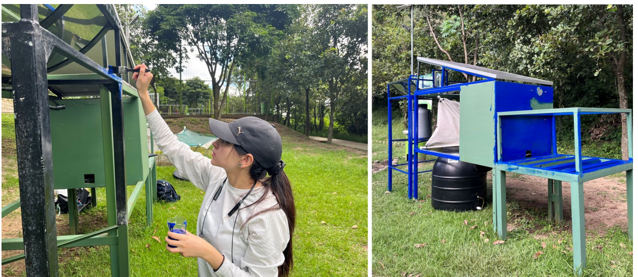
Figura 79: Aplicación de pintura anticorrosiva.
