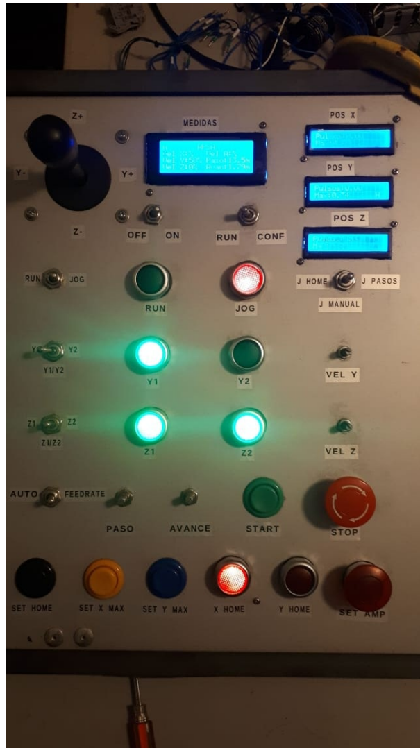
Figura 6.4: Prueba de funcionamiento de paneles de operador.
