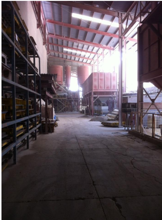
Imagen 30: Tanques de almacenamiento de cemento para fabricación de blocks
