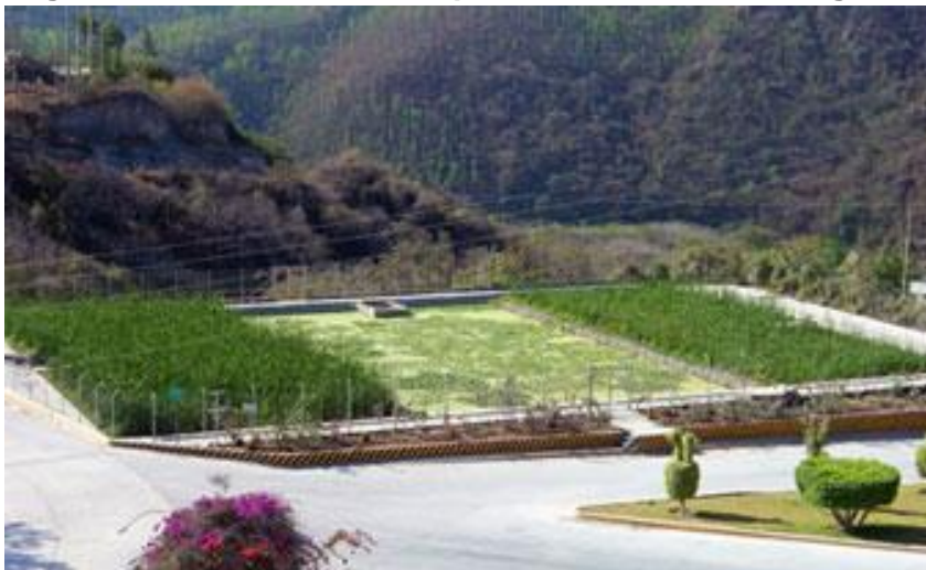
Imagen 134: Pantano artificial para la reutilización de agua
