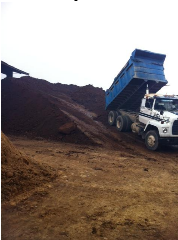
Imagen 45: Proceso de descarga de arcilla en bancos de depósito
