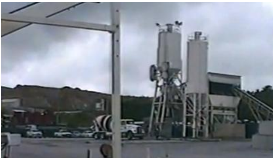
Imagen 81: Descarga de concreto en camiones agitadores
