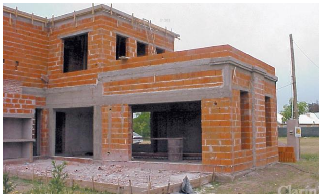
Imagen 15: Distribución de aberturas en muros
