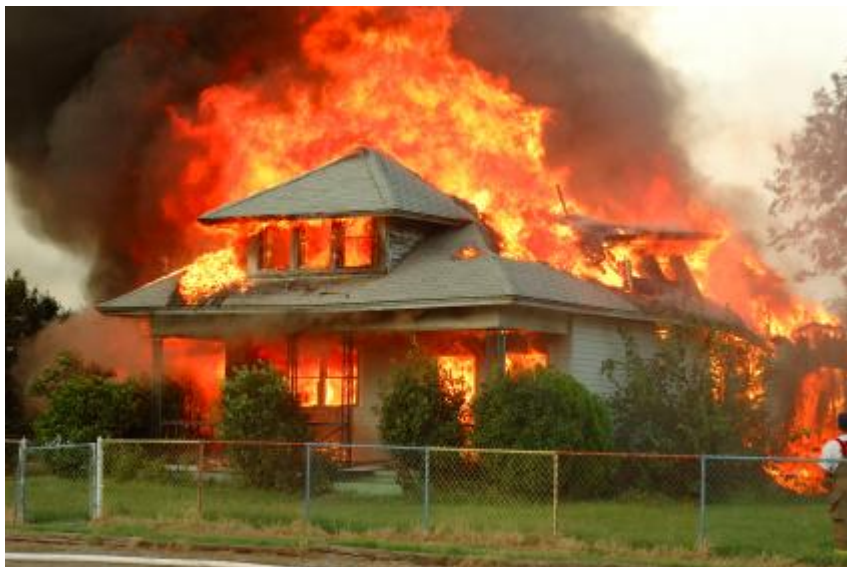
Imagen 194: Vivienda de madera bajo un incendio.
