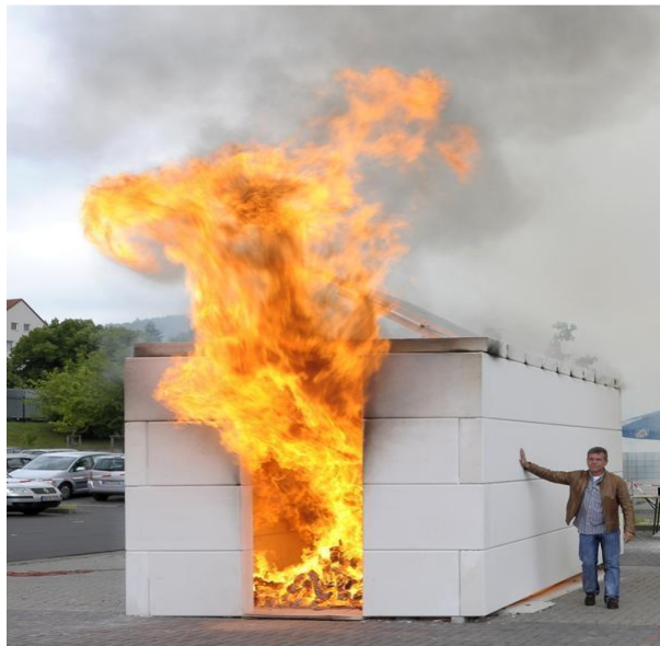
Imagen 196: Edificación de concreto bajo un incendio.
