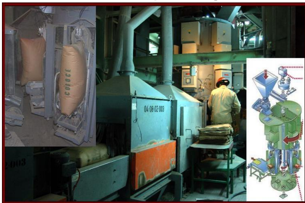
Imagen 76: Proceso de despacho a granel de cemento.
