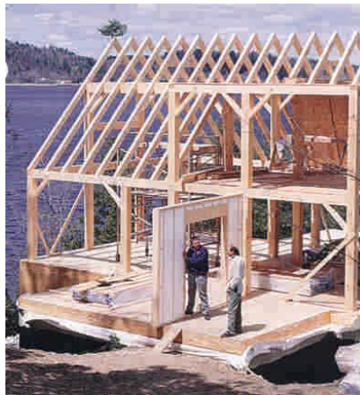
Imagen 14: Construcción de estructuras de poste y viga
