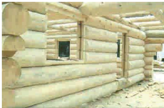
Imagen 12: Construcción de estructuras macizas
