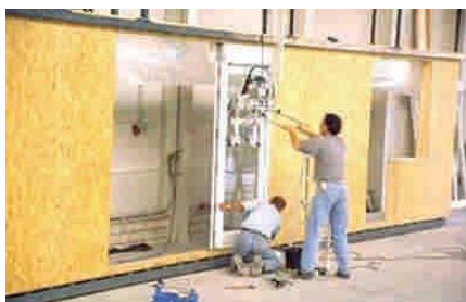
Imagen 13: Construcción de estructuras de placas
