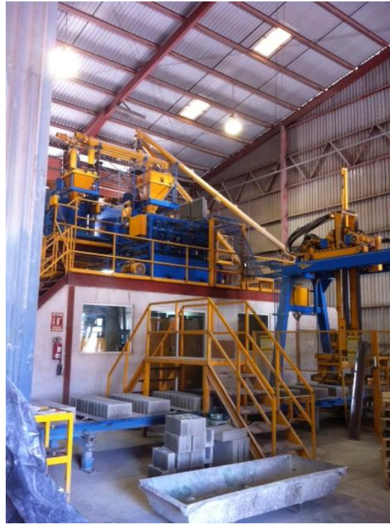
Imagen 37: Tolvas que descargan el material para ser mezclado e iniciar el proceso de fabricación de blocks
