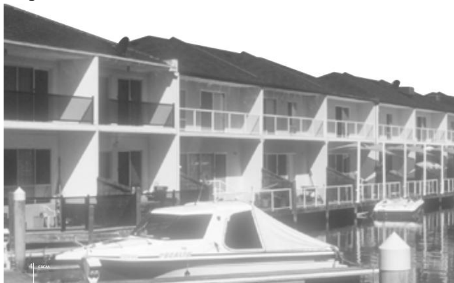
Imagen 6: Viviendas construidas en serie, de muros de concreto
