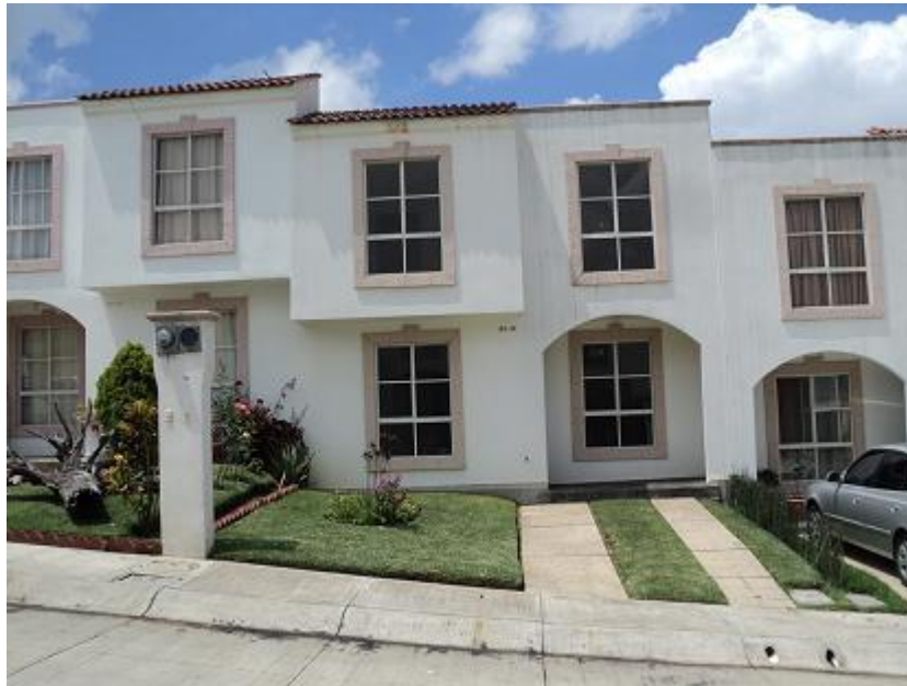
Imagen 17: Condominio de mampostería
