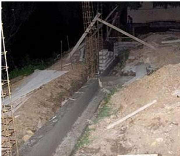
Imagen 16: Cimentación de muros de mampostería
