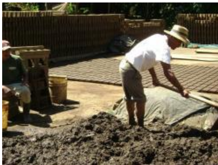
Imagen 49: Proceso de molienda de la arcilla en un proceso artesanal
