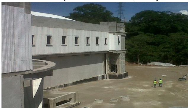
Imagen 5: Muros de panel estructural, con y sin mortero
