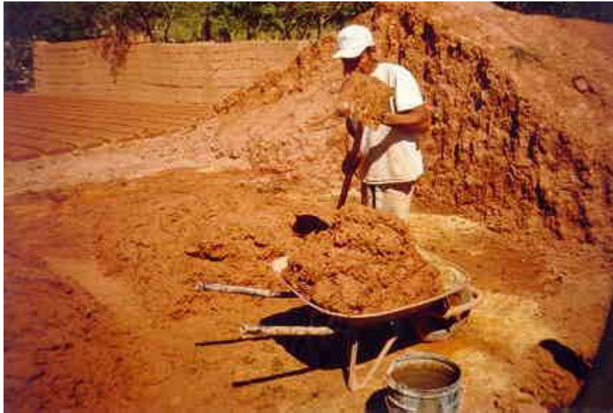
Imagen 43: Proceso de extracción de arcilla de forma artesanal cortando en capas del mismo terreno
