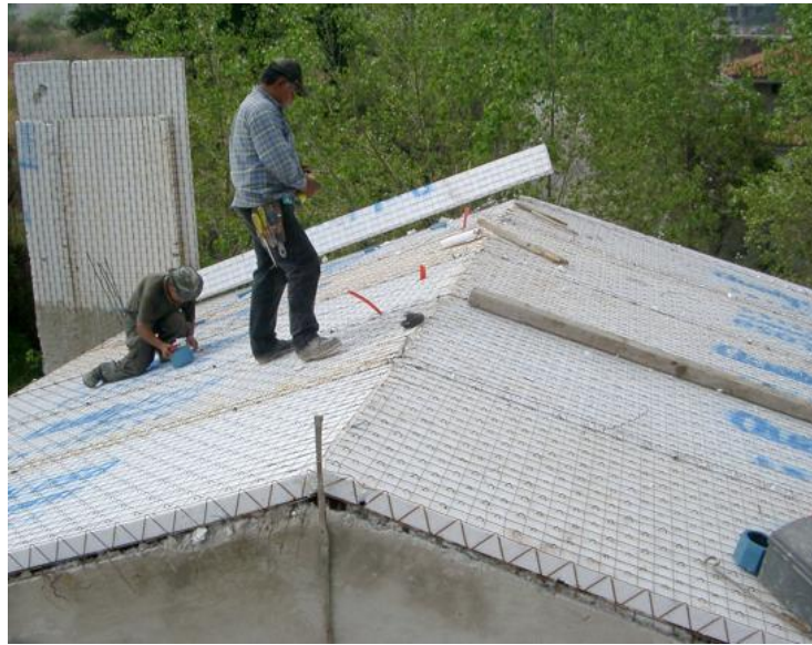
Imagen 180: Uso de electro panel.
