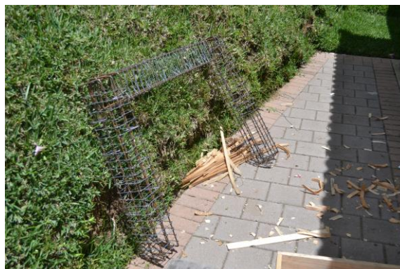
Imagen 10. Armadura del marco a escala.
