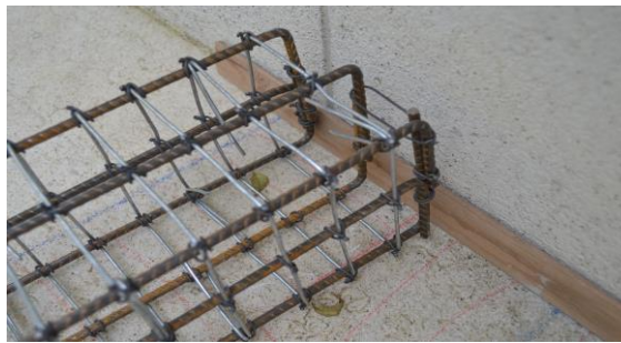
Imagen 9. Armadura de columnas y vigas del marco a escala.
