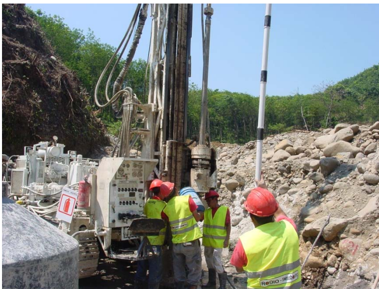
Ilustración 24: Tubería con manchetas
