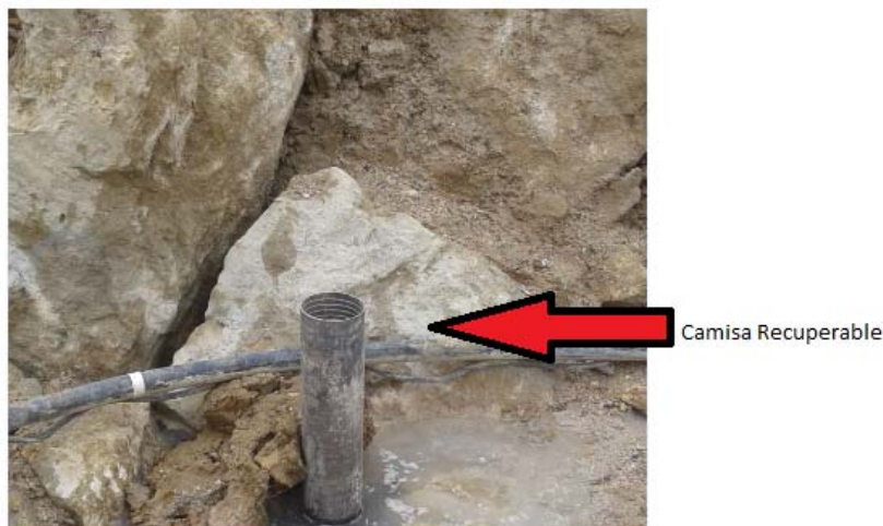
Ilustración 41: Camisa recuperable de perforación
