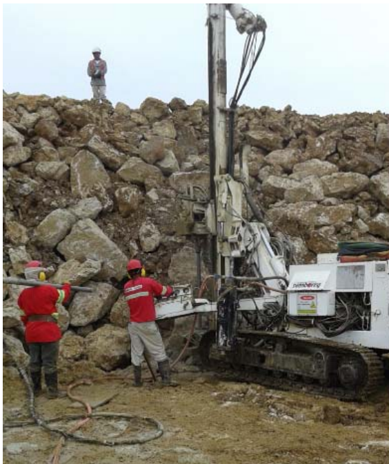
Ilustración 42: Perforación de taladro
