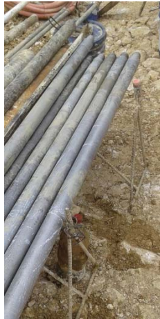
Ilustración 46: Tubería de perforación
