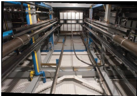
Ducto de un elevador
