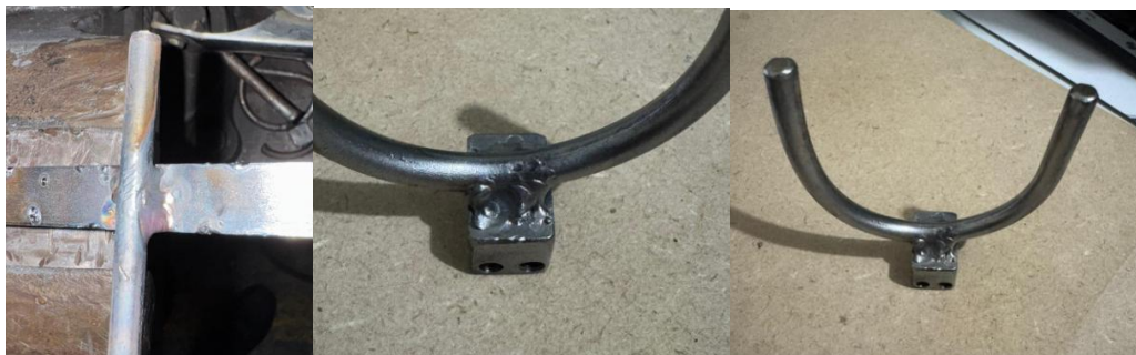
Figura 27. Soldadura de “U” a acoples
