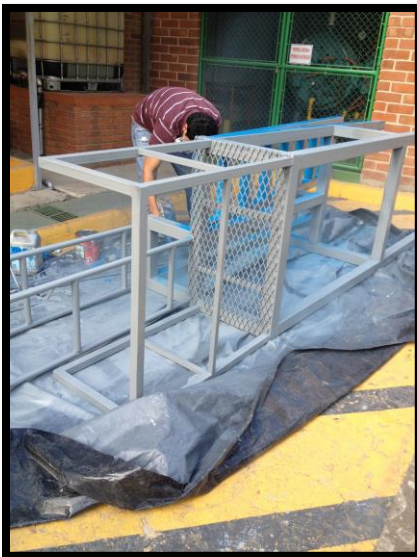
Figura No. 32 Fase de pintura
