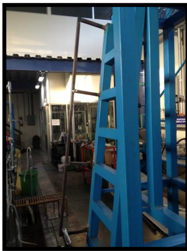
Figura No. 34 Implementación de baranda a escaleras de la estructura
