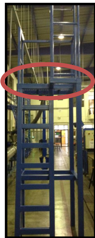
Figura No. 11 Estructura de la torre de pared mojada con malla metálica
