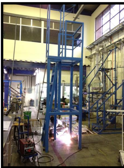
Figura No. 35 Soldadura de zapatas para anclaje al suelo
