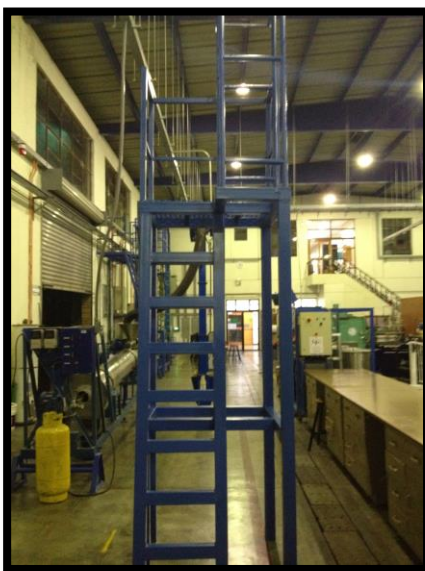
Figura No. 33 Estructura pintada
