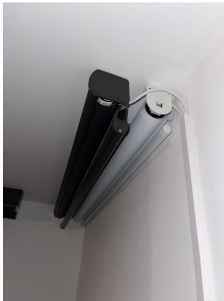
Figura 35. Imagen capturada dentro de la vivienda mostrando el motor ya instalado en persianas.
