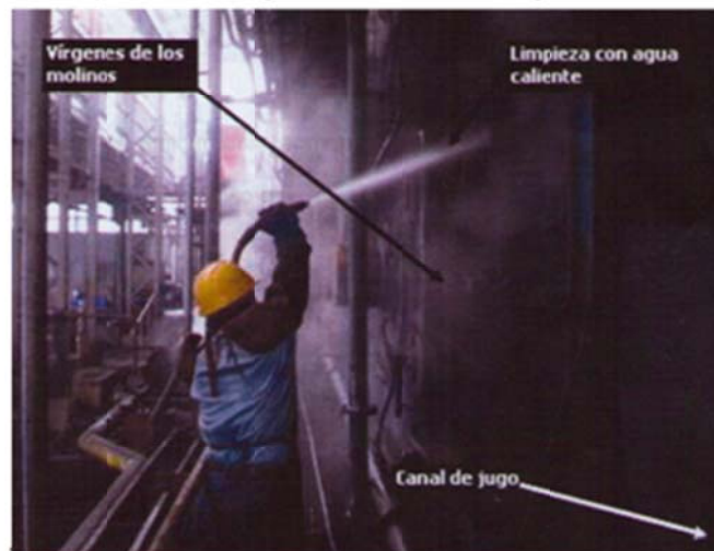
Figura 2. Aplicación de agua caliente en las vírgenes de los molinos.
