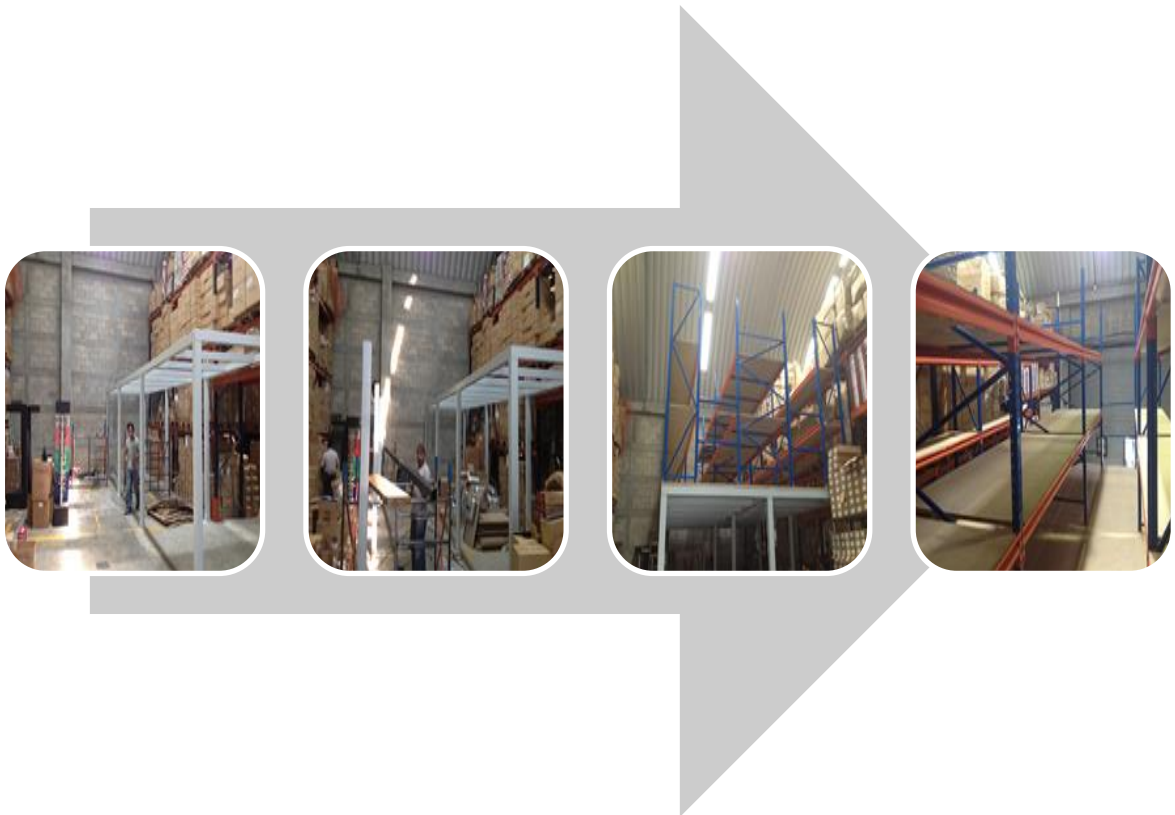
Imagen 22: Construcción del mezzanine.
