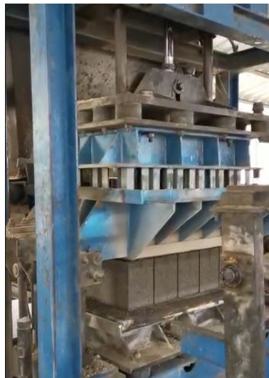
Figura 21. Extrusión de los bloques de concreto
