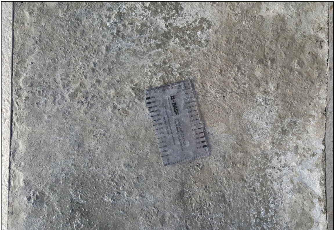
Gráfico 38: Fisura en muestra de concreto testigo 4000 PSI tamaño máximo de 3/4"
