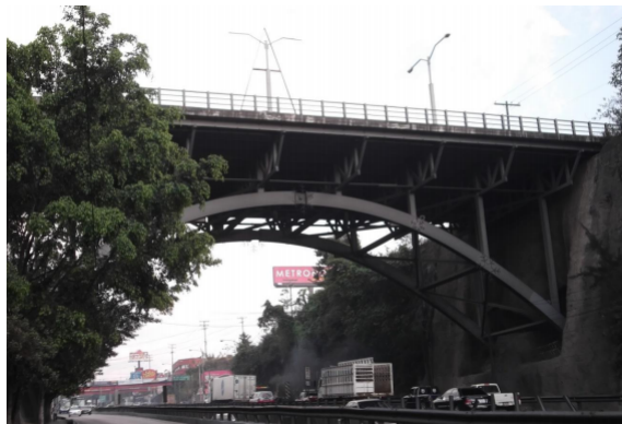
Figura 10: Puente Los Alamos, ciudad de Guatemala (C. E. Muñoz, 2013)
