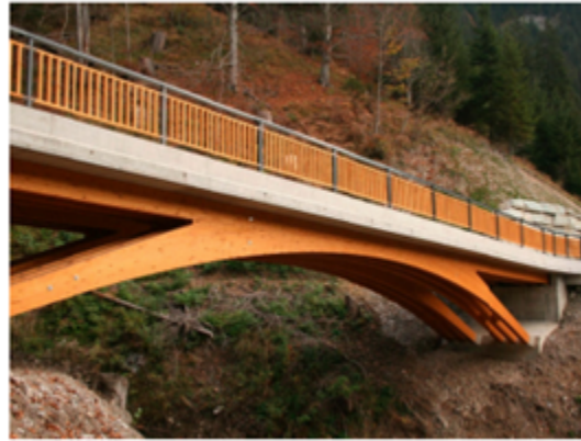
Figura 1: Puente Ragoztobellrücke, en Graubünden, Suiza. (C. E. Muñoz, 2013)
