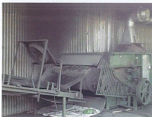
Figura 11. Producto a la salida del horno
