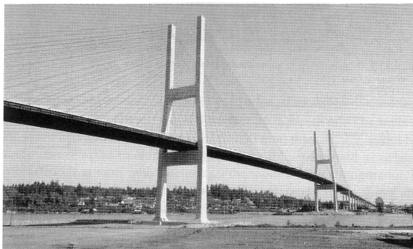
Figura 43: Vista del puente Annacis Island.
