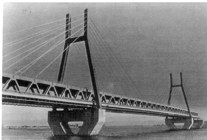
Figura 38: Foto de puente Rokko.
