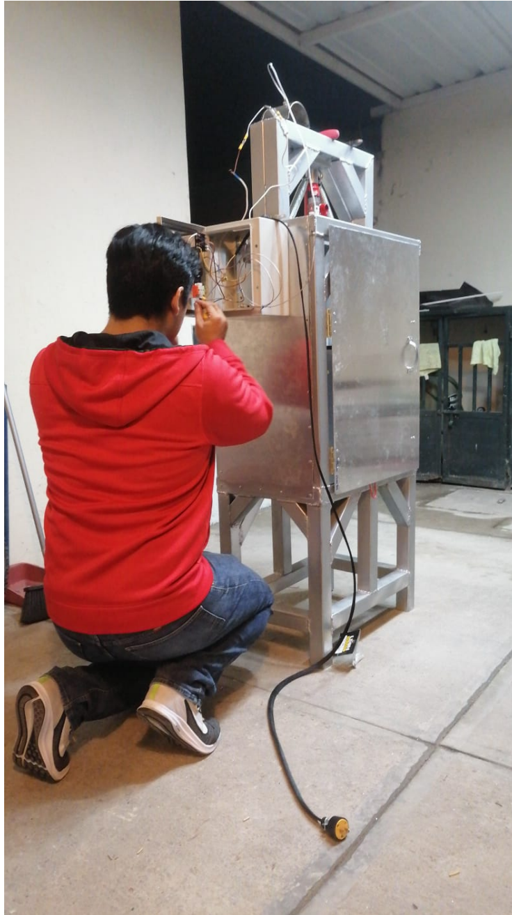
Figura 34: Proceso de conexión de sistema eléctrico
