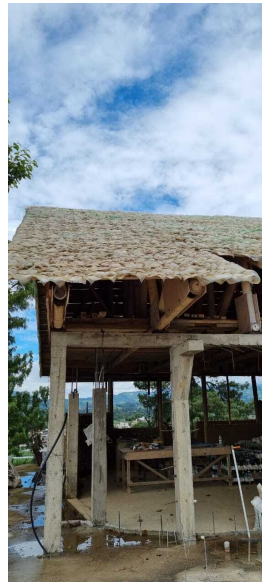
Figura 12: Techo construido a base de tejas de plástico PET
