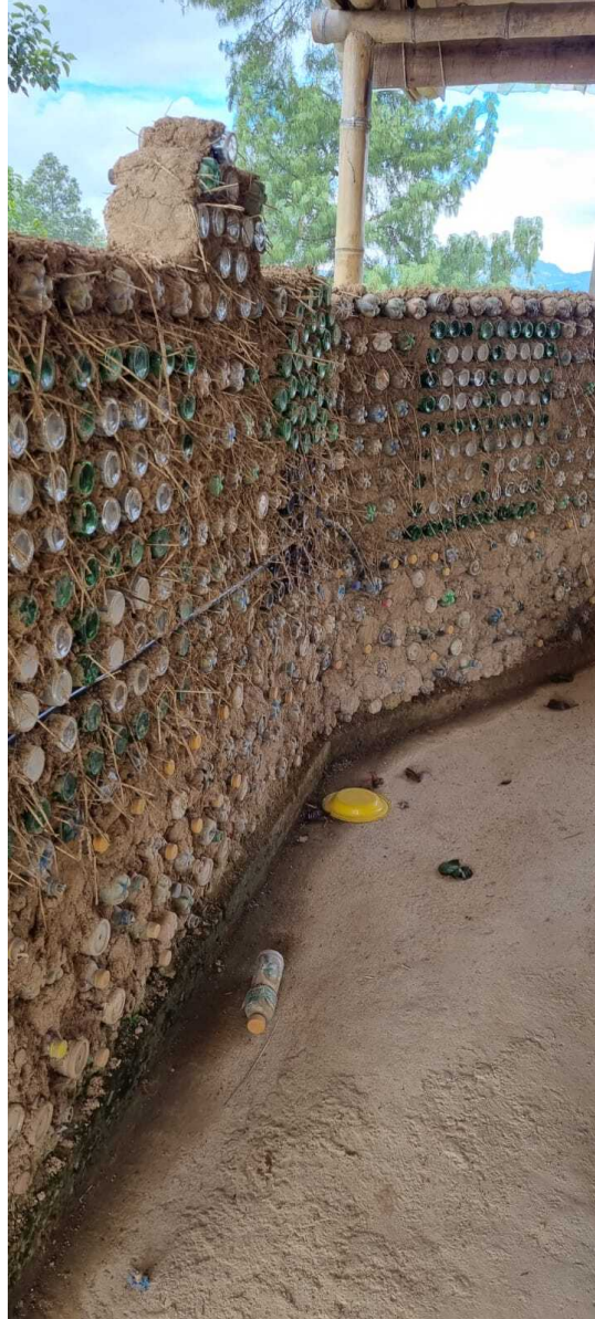
Figura 13: Muro construido a base de ecoladrillos
