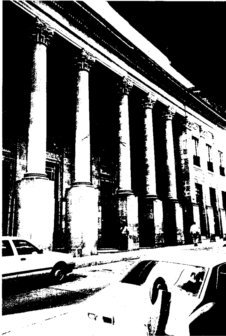
10. Fachada posterior del Palacio Municipal. Nótese el tamaño de los pedestales.
