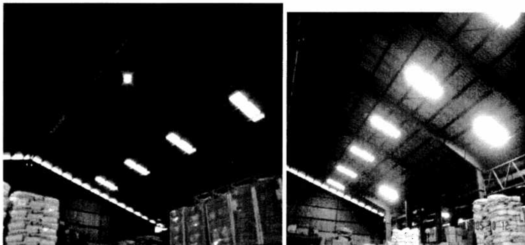
Figura # 49: Mejora en iluminación en área de piso de bodega 6
