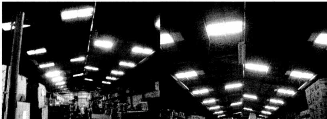
Figura # 41: Cambio de tragaluces en la nave principal de la bodega 1
