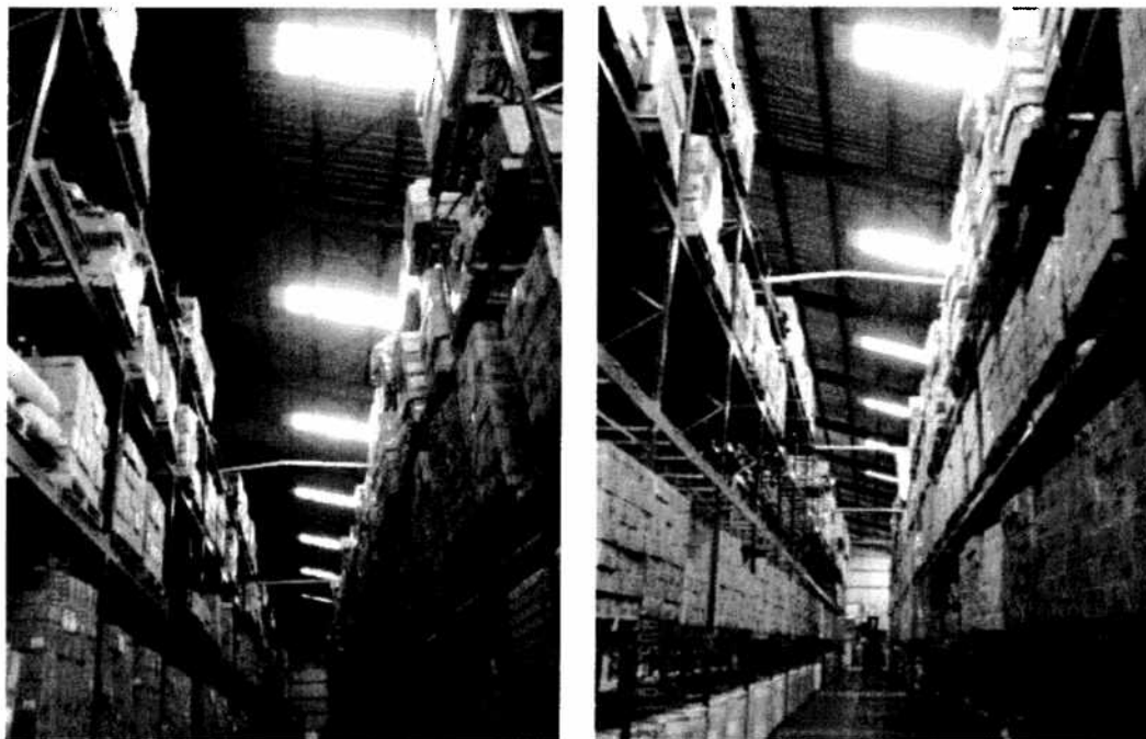
Figura # 46: Mejora en iluminación en pasillo 2 de bodega 6, área de estanterías
