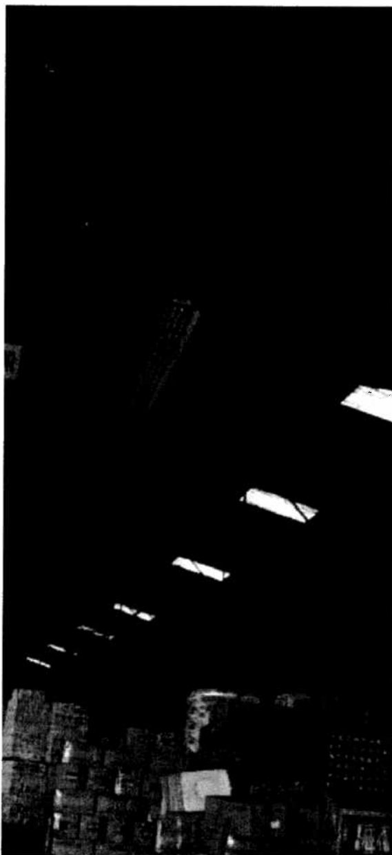
Figura # 18: Área de piso en la bodega 7. Tragaluces actuales
