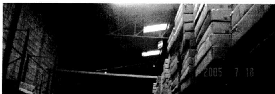
Figura # 19: Tragaluces en pasillo de bodega 7, área de estanterías
