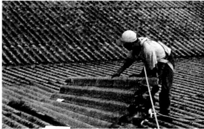
Figura # 43: Cambio de tragaluces y equipo de seguridad
