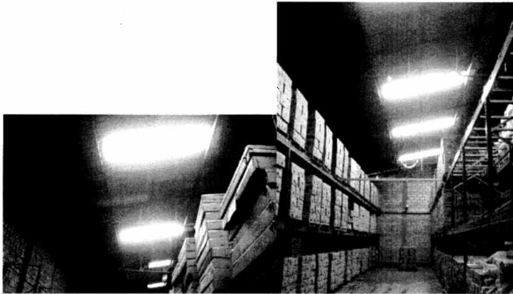
Figura # 50: Mejora en iluminación en área de estanterías en bodega 7
