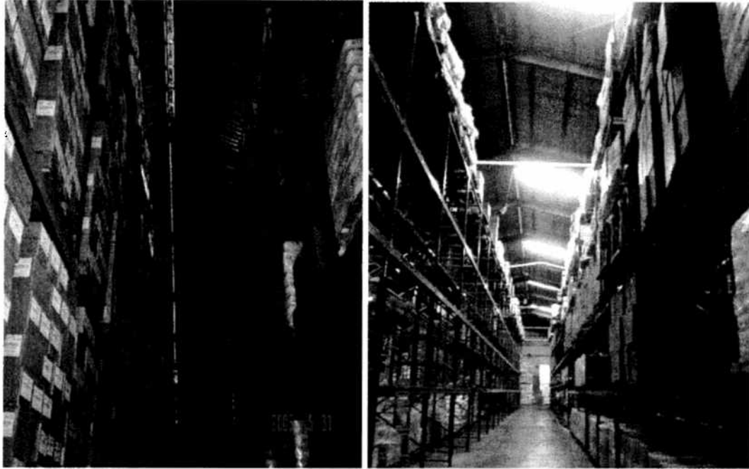
Figura # 47: Mejora en iluminación en pasillo 3 de bodega 6, área de estanterías
