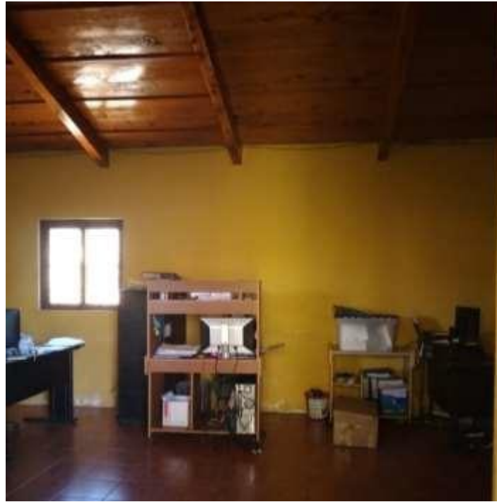
Figura III-1: Ubicación de ventana en el Salón A (aproximadamente misma altura en Salón B).
