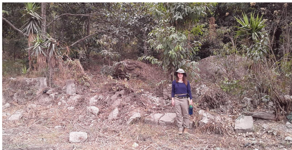
Figura II-11: vista del muro perimetral al norte (el acceso se ve a la derecha de la imagen) (Foto por E. Arredondo).
