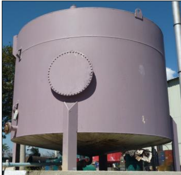
Figura 6. Tanque de retención
