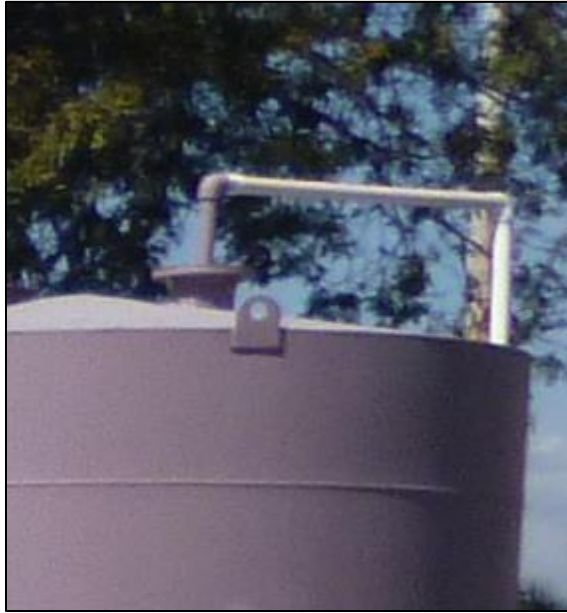
Figura 14. Llenado del tanque de almacenamiento.
