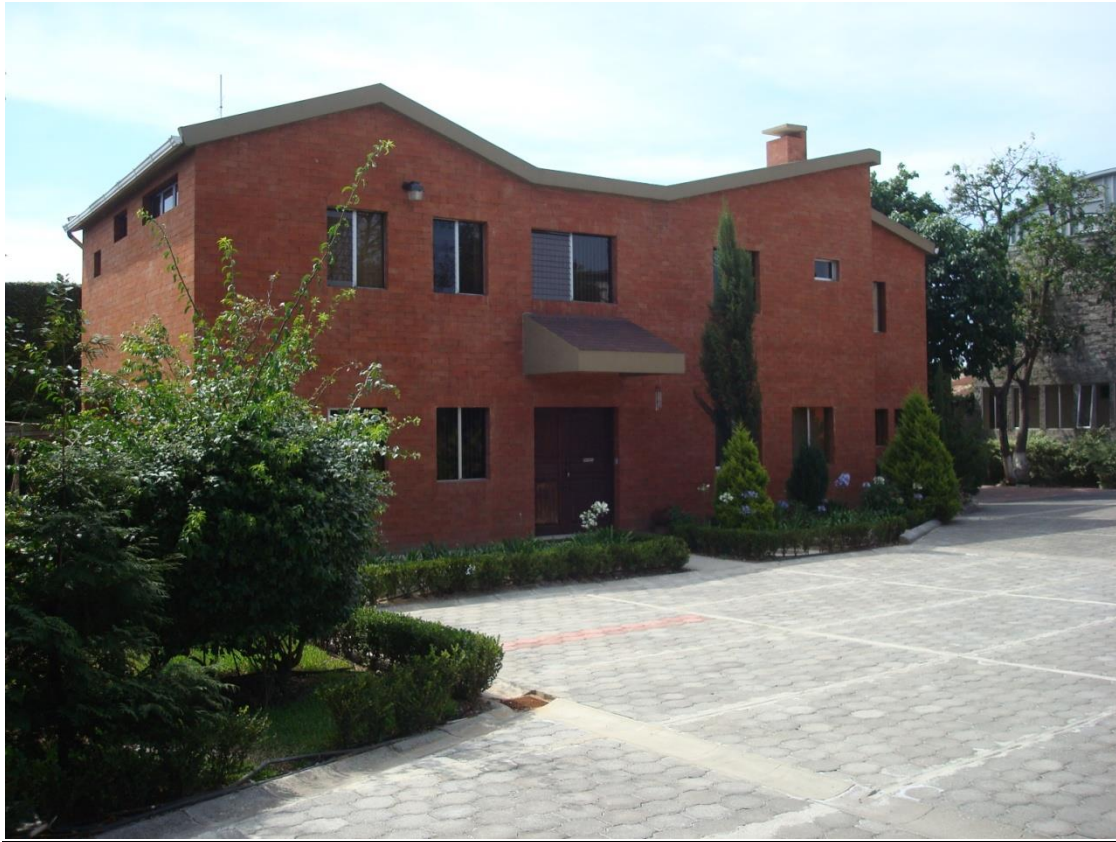
Ilustración 1: Edificio de Administración
