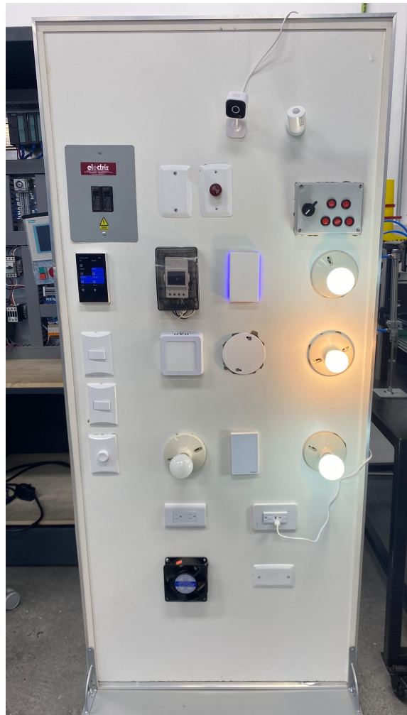
Figura 17. Pruebas de funcionamiento del tablero
