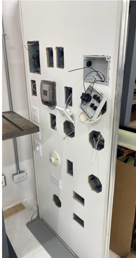
Figura 16. Tendido del cableado
