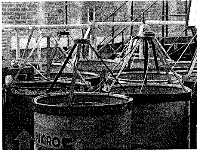
Fotografía 20: Identificación de contenedores de cable principal
