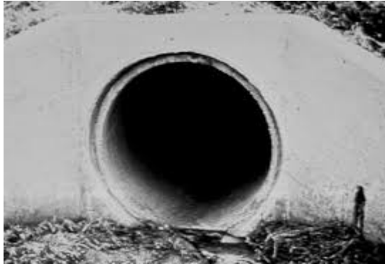
Figura 4. Ejemplo de alcantarilla de secciones circulares
