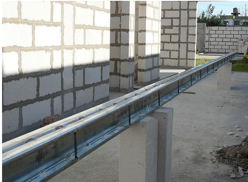
Ilustración 150: Unión de costaneras por soldadura reforzado con hierro de 3/8"
