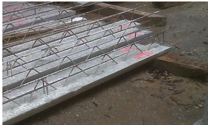
Figura 124: Viguetas (vista lateral)
