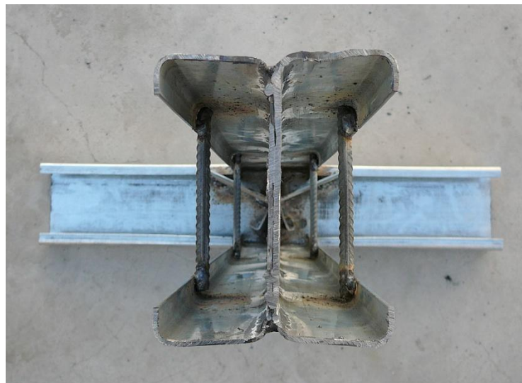
Ilustración 151: Puntos de soldadura en unión de costaneras
