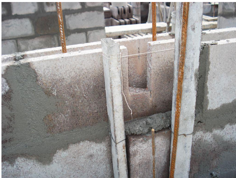
Ilustración 92: Colocación de tubos rectangulares para colocar la cuerda guía de cada eje
