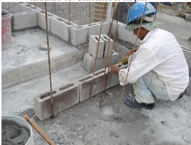
Ilustración 93: Colocación de bloques
