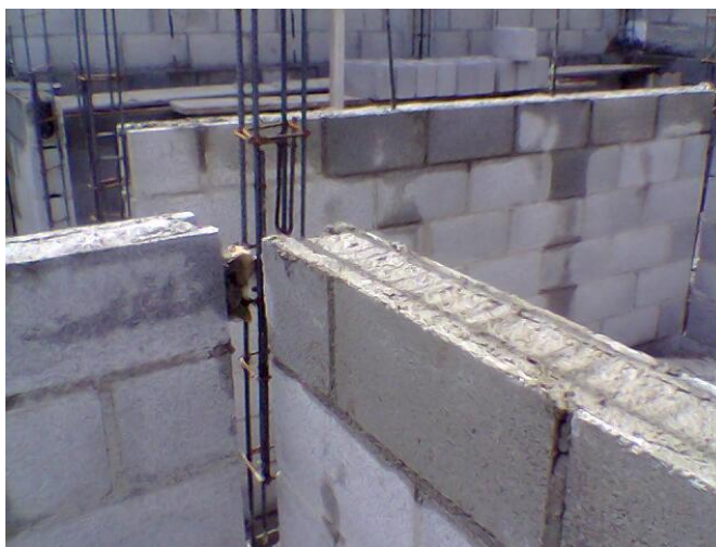
Ilustración 74: Solera intermedia fundida
