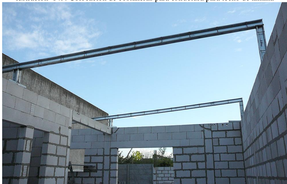
lustración 149: Colocación de costaneras para estructura para techo de lámina
