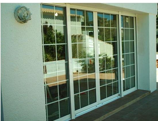
Ilustración 58: Muro con aberturas
