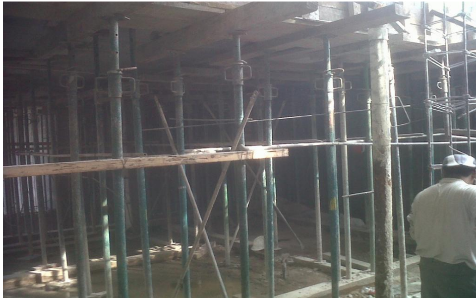
Ilustración 114: Apuntalado en obra
