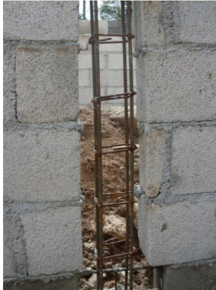
Ilustración56 : Columna de mampostería confinada
