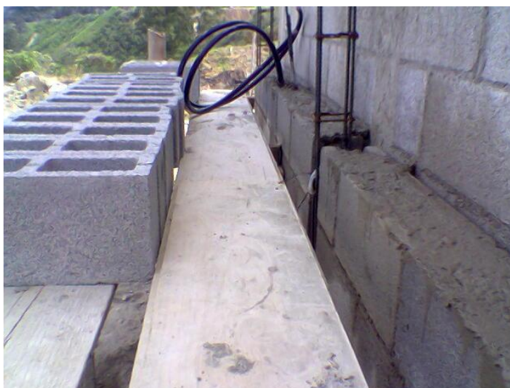
Ilustración 72: Muro confinado juntas llenas
