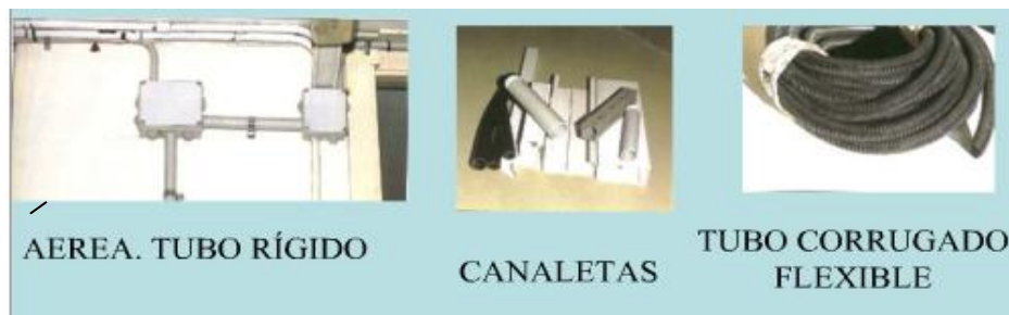
Ilustración 31: Canalizaciones
