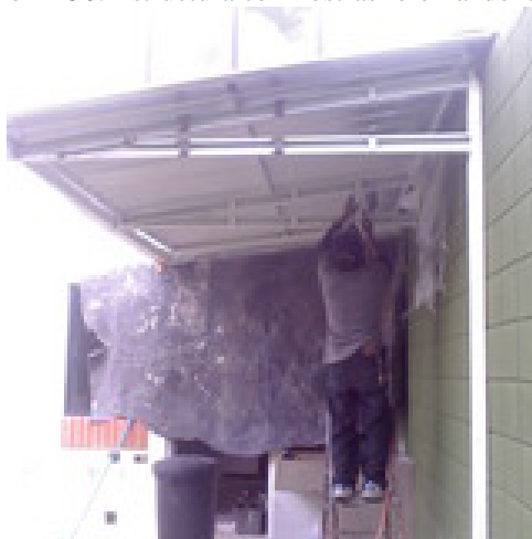
Ilustración 150: Estructura con riostras reforzando las vigas
