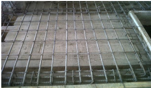
Figura 117: Armado de refuerzo
