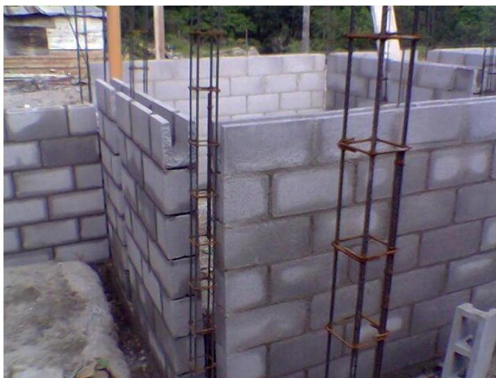
Ilustración 73: Detalle de solera intermedia y esquina
