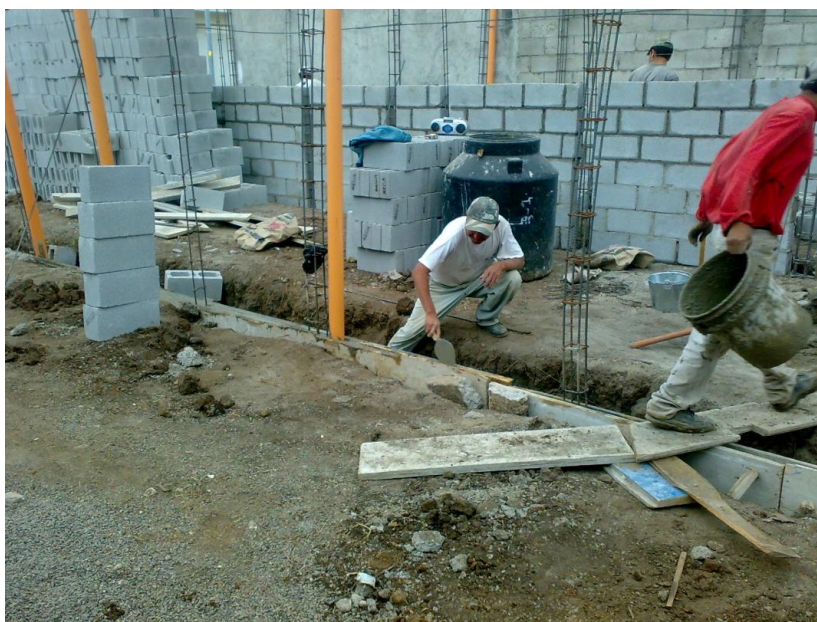
Ilustración 71: Levantado de muro sobre cimiento
