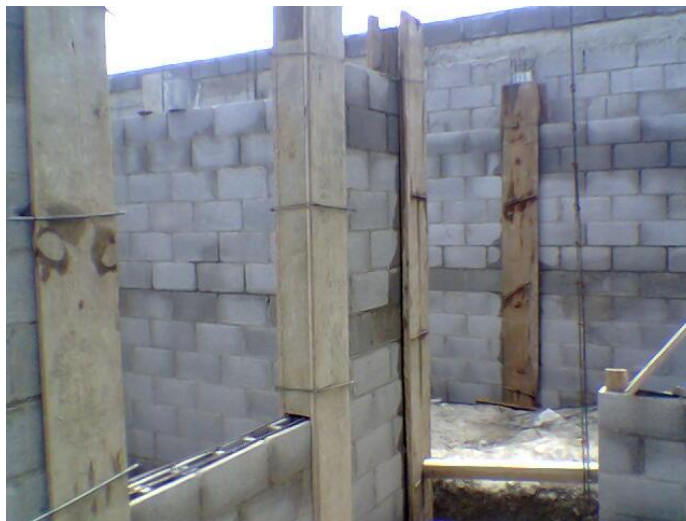
Ilustración 75: Detalle de vanos
