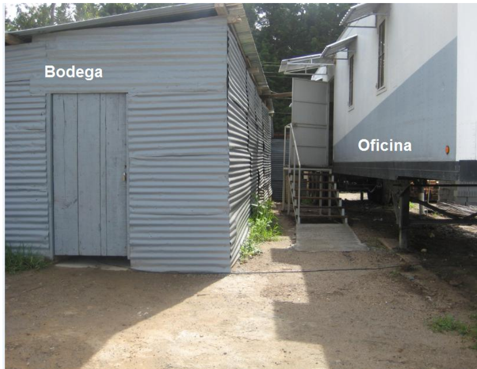
Ilustración 6: Campamento de Obra
