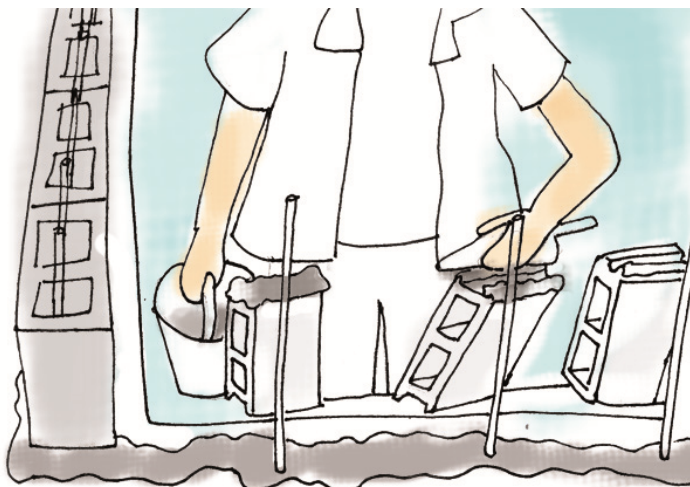
Ilustración 95: Colocación de mortero
