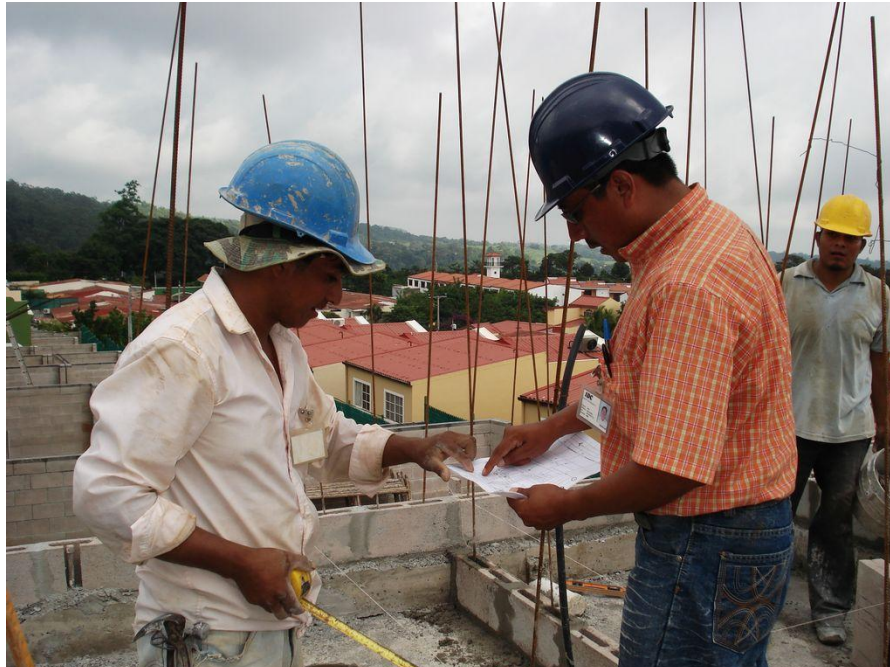
Ilustración 91: Revisión de planos en conjunto con el maestro de obra
