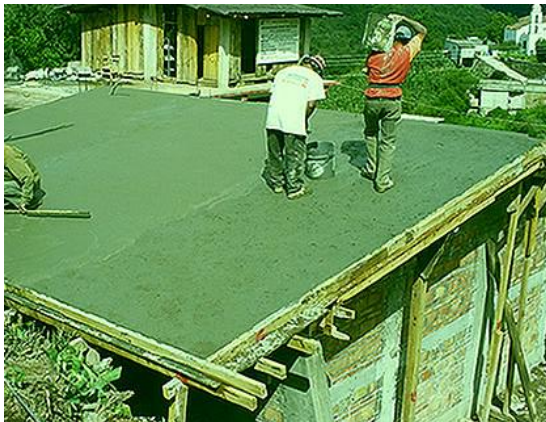
Ilustración 140: Losa de concreto fundido
