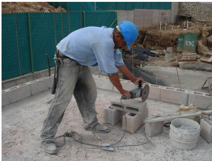
Ilustración 94: Corte de ajuste con cortadora mecánica
