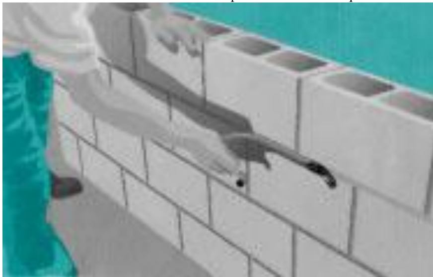
Ilustración 99: Medición de espaciamiento entre bloques
