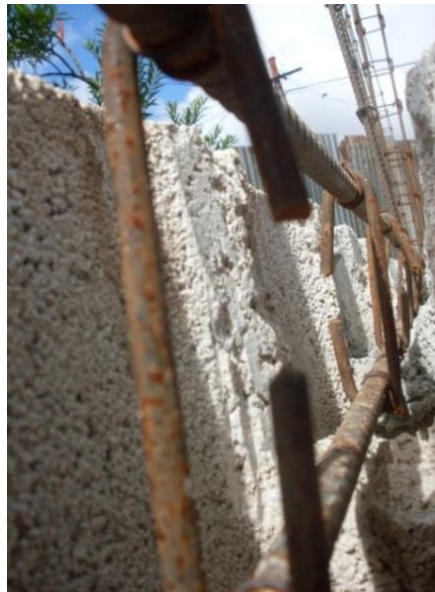
Ilustración 57: Solera en mampostería confinada
