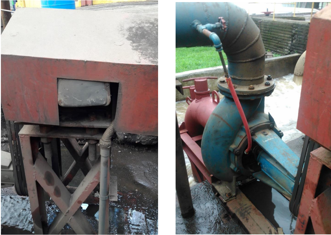
Figura 64. Bomba centrífuga de etapa simple y motor
