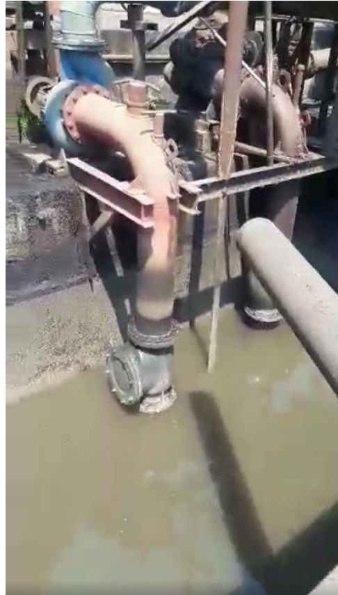
Figura 66. Succión bombas
