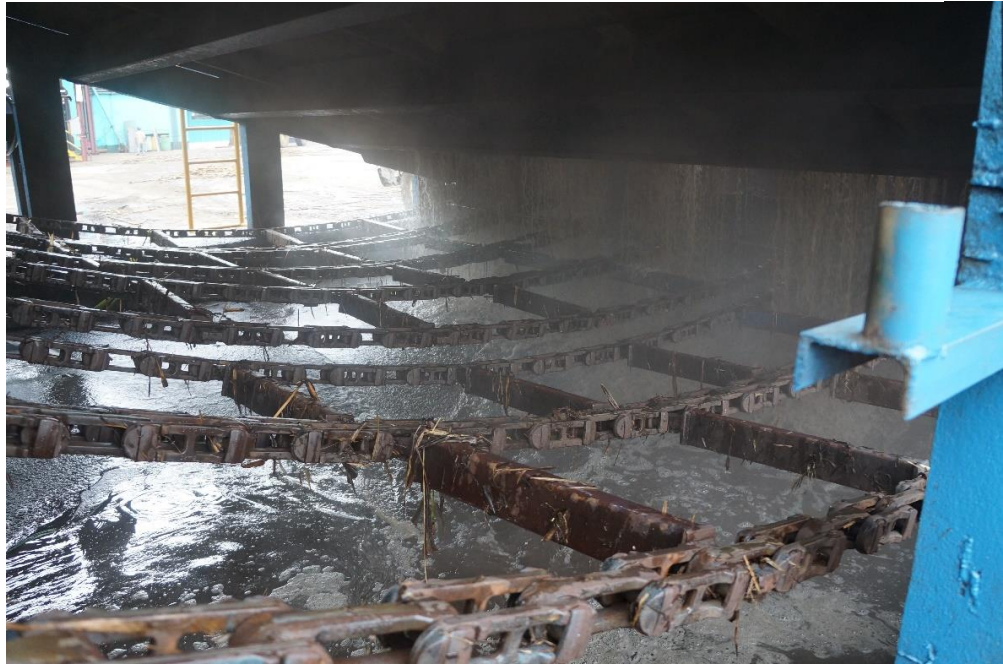
Figura 79. Descarga de agua mesa de lavado de caña 1
