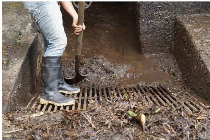
Figura 95. Limpieza de los lodos del efluente de las mesas de lavado de caña
