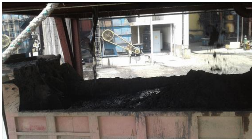
Figura 113. Extracción y transporte de lodos de planta de tratamiento hacia campos de caña
