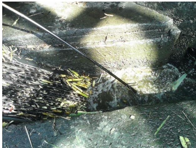
Figura 94. Limpieza manual de las cribas
