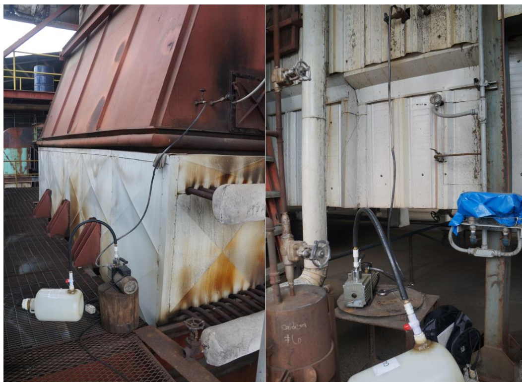
Figura 34. Imagen izquierda sistema de extracción de gases de combustión en salida de gases de caldera 5; imagen derecha, el mismo sistema para la caldera 6.
