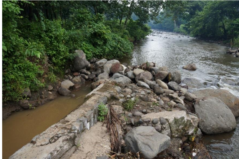
Figura 90. Río Sis, fuente de agua del Ingenio Tumulá, S.A
