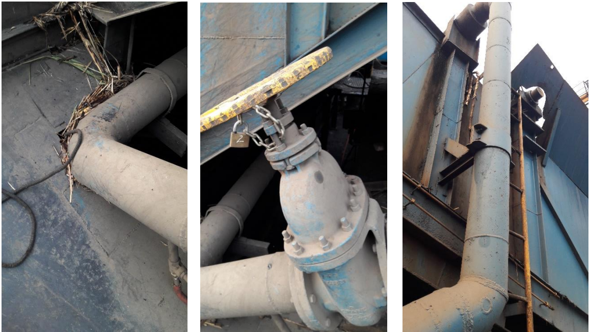
Figura 73. Sistema alimentación de agua mesa de lavado 1
