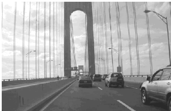
Fotografías veinte y veintiuno: Puente Verrazano-Narrows. Luz principal 4,260.00 pies. Luz total 13,700.00 pies. Construido entre 1959-1964.
