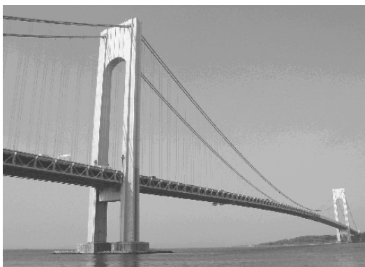
Fotografías veinte y veintiuno: Puente Verrazano-Narrows. Luz principal 4,260.00 pies. Luz total 13,700.00 pies. Construido entre 1959-1964.
