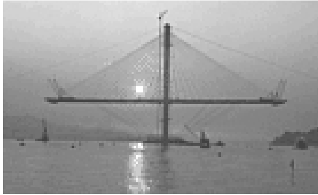
Fotografía diez: Construcción de puentes por voladizos sucesivos.
