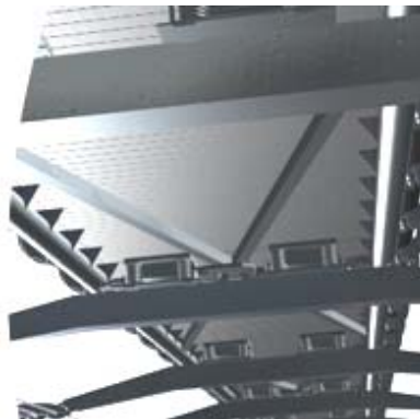
Fotografía veintidós: Ver como se apoyan los amortiguadores de "masa afinada" entre la losa y las vigas transversales de modo que transfieran los movimientos de ladeo.
