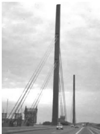
Fotografía nueve: Puente Norderelbe
