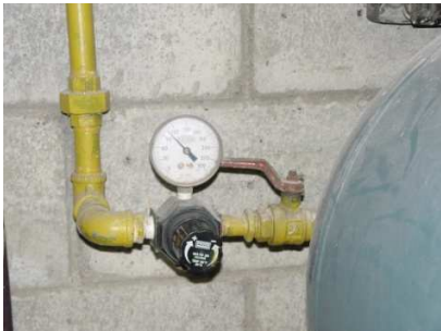
Figura 28: Válvula de purga del depósito de aire
