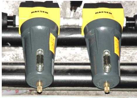
Figura 15: Filtros KOR35 y KVF35 respectivamente
