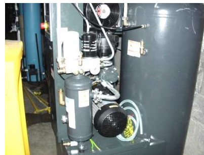
Figura 10: Interior derecha de compresor
