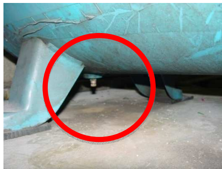
Figura 28: Válvula de purga del depósito de aire
