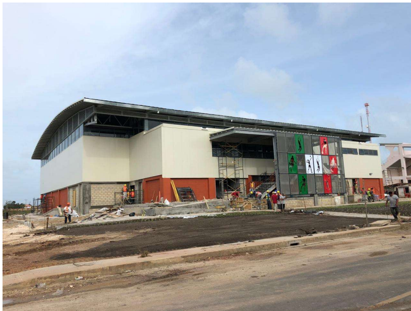
Figura no. 49: Edificación real concluida..
