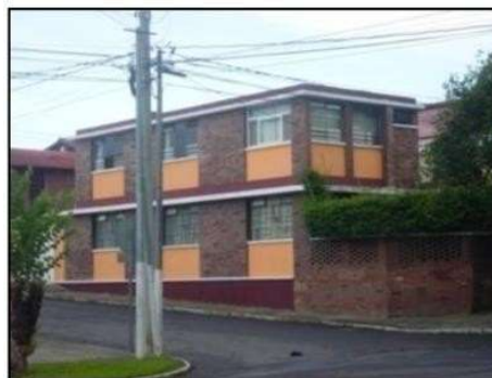
Figura no. 8: Edificación de mampostería reforzada.
