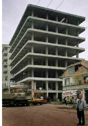
Figura no. 11: Edificación de concreto reforzado.
