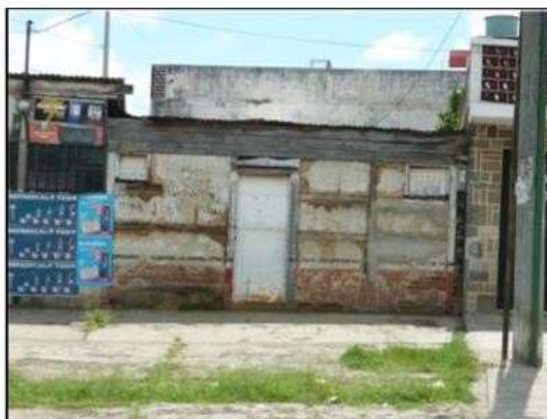
Figura no. 5: Edificación con bahareque.
