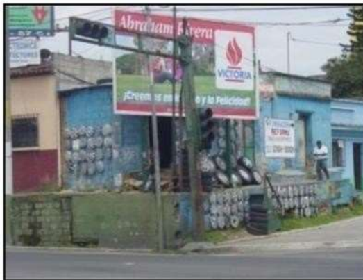
Figura no. 6: Edificación de mampostería simple.
