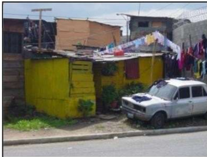
Figura no. 3: Edificación con muros de madera.
