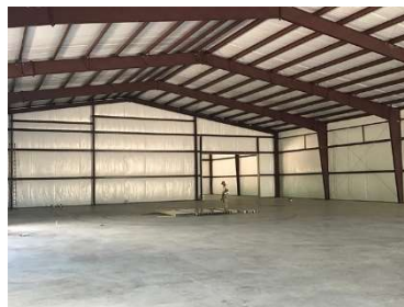
Figura no. 10: Edificación de acero estructural.
