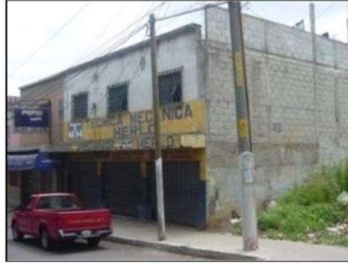
Figura no. 7: Edificación de mampostería confinada.
