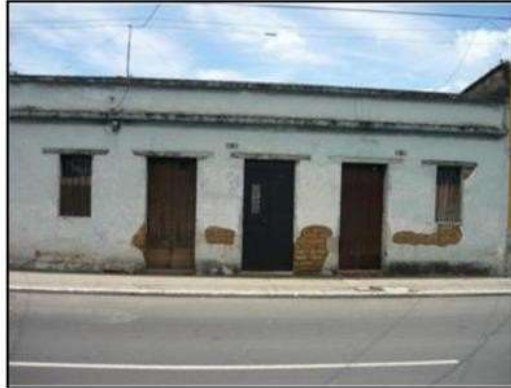
Figura no. 4: Edificación con adobe.
