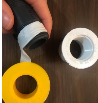
Figura no.18 “Colocación de teflón en roscas”
