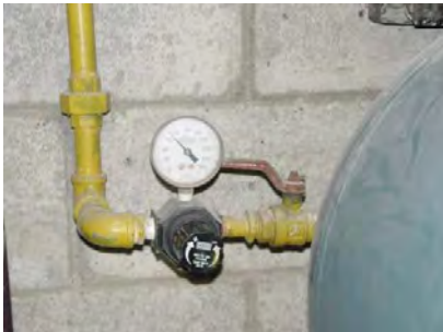
Figura 28: Válvula de purga del depósito de aire
