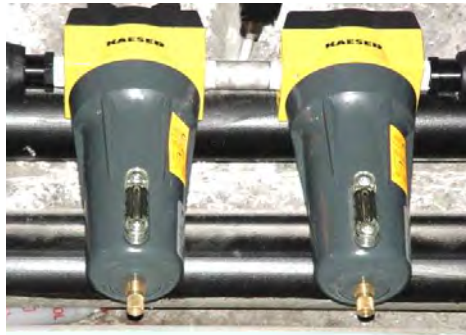
Figura 15: Filtros KOR35 y KVF35 respectivamente
