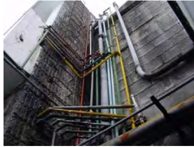
Figura 32: Distribución de tubería hacia puntos de uso
