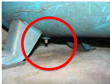
Figura 28: Válvula de purga del depósito de aire
