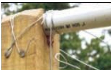
Figura 78: Colocación de los cables guías
