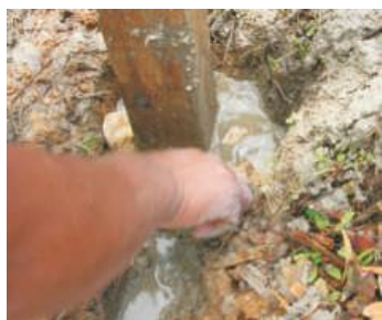
Figura 73: Instalación de los postes de madera
