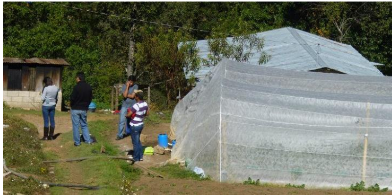
Figura 47. Área de ingreso a los Macrotúneles
