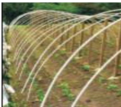
Figura 77: Colocación de los tubos galvanizados
