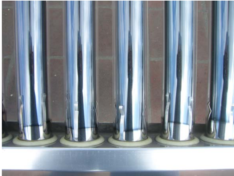
Figura 2.10 Vista de tubos de un sistema termosifón
