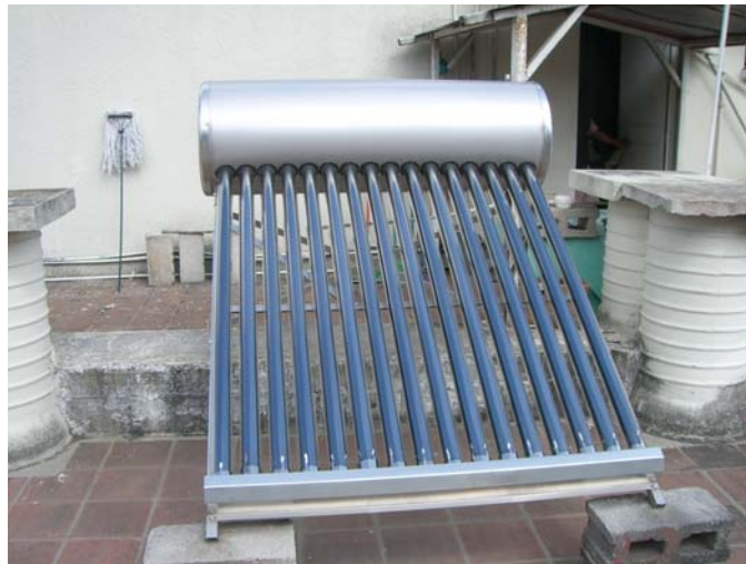
Figura 2.8 Vista frontal de un sistema termosifón
