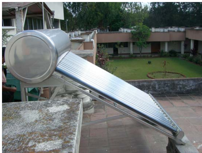
Figura 2.9 Vista lateral de un sistema termosifón
