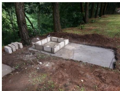
Ilustración 26: Colocación de la estructura metálica del biofiltro y tanques para humedales.
