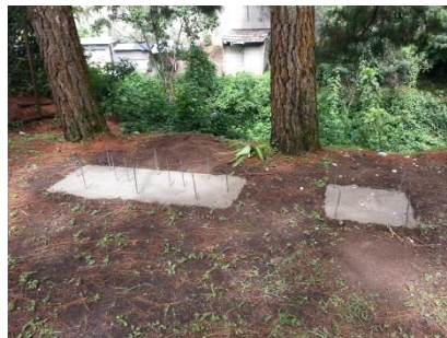
Ilustración 24: Fundición de bases de cemento para soporte de fosa séptica y estructura metálica para el biofiltro.
