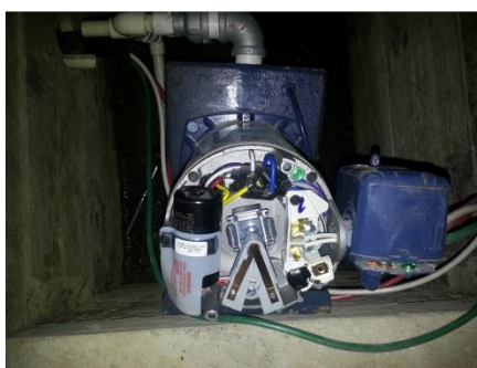
Ilustración 34: Detalle interno del motor de la bomba centrífuga.
