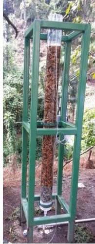
Ilustración 39: Pruebas de arranque del biofiltro con agua potable.
