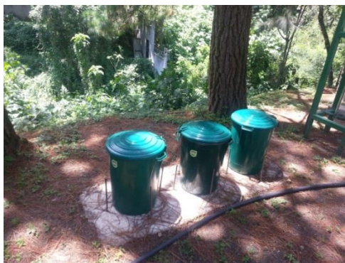
Ilustración 27: Colocación de cubetas con tapadera de 40 L de capacidad para fosa séptica.
