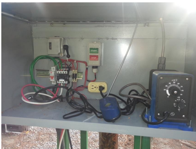
Ilustración 33: Instalación de caja metálica de 70x35x30 cm adjunta a la estructura metálica del biofiltro.
