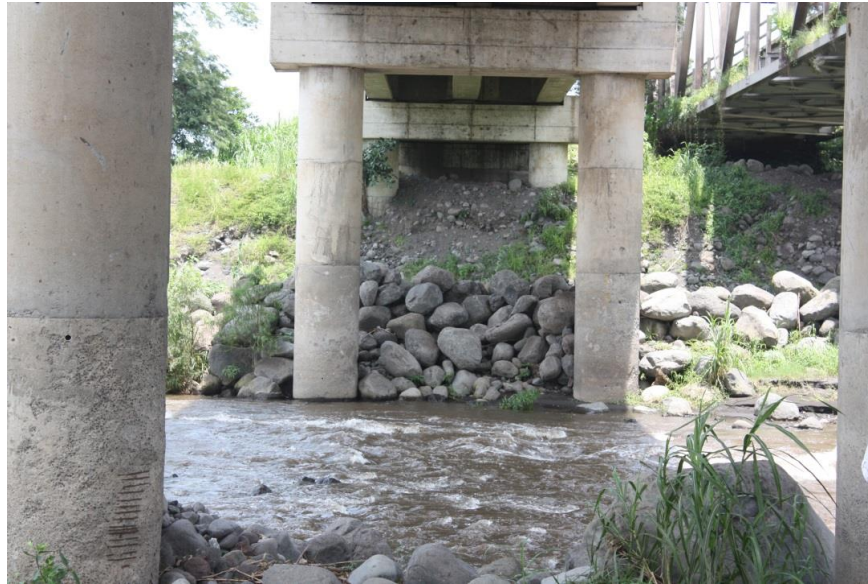
Figura No. 206. Vista de la subestructura del puente Guacalate en la CA-02 en el Km 62.5
