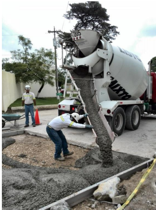
Figura No. 251. Vertido de losa de concreto convencional.
