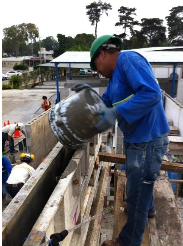
Figura No. 258. Fundición de muro.
