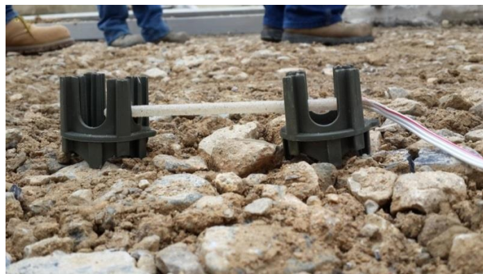
Figura No. 35 Strain Gauge colocado.
