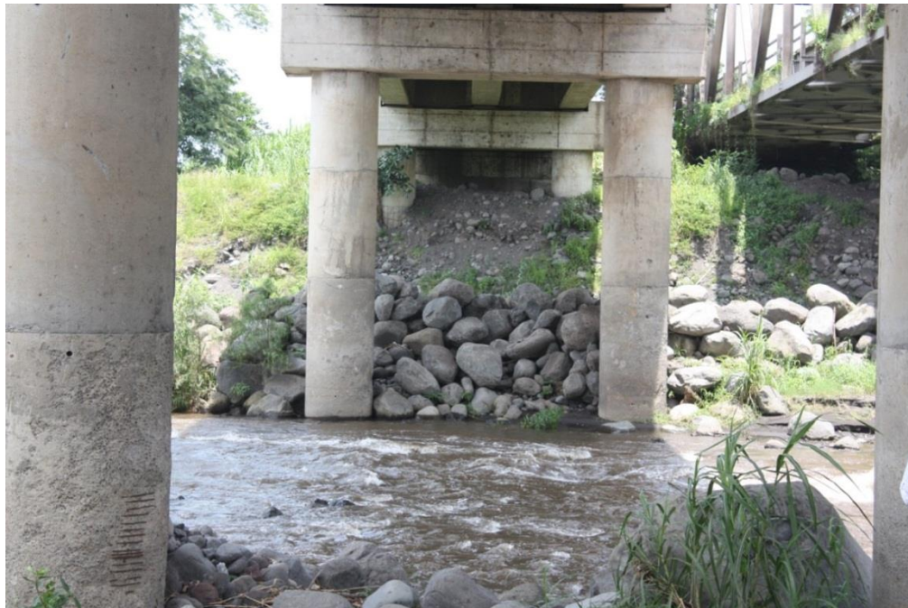
Figura No. 199. Vista del río Guacalate bajo el puente de concreto reforzado.
