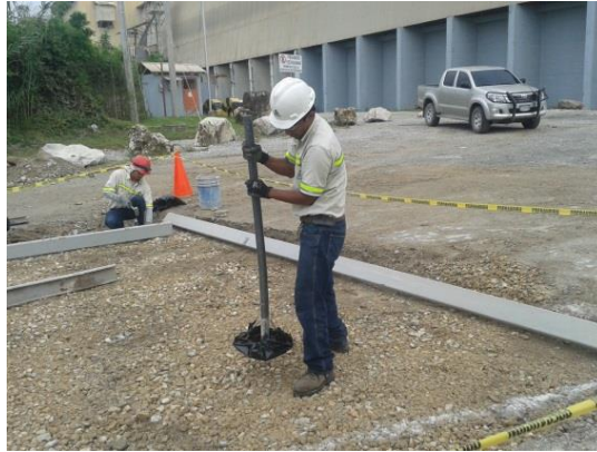
Figura No. 77 Compactación del terreno.
