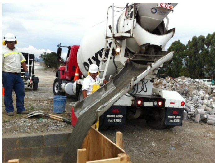
Figura No. 135 Concreto utilizado para fundir muro.
