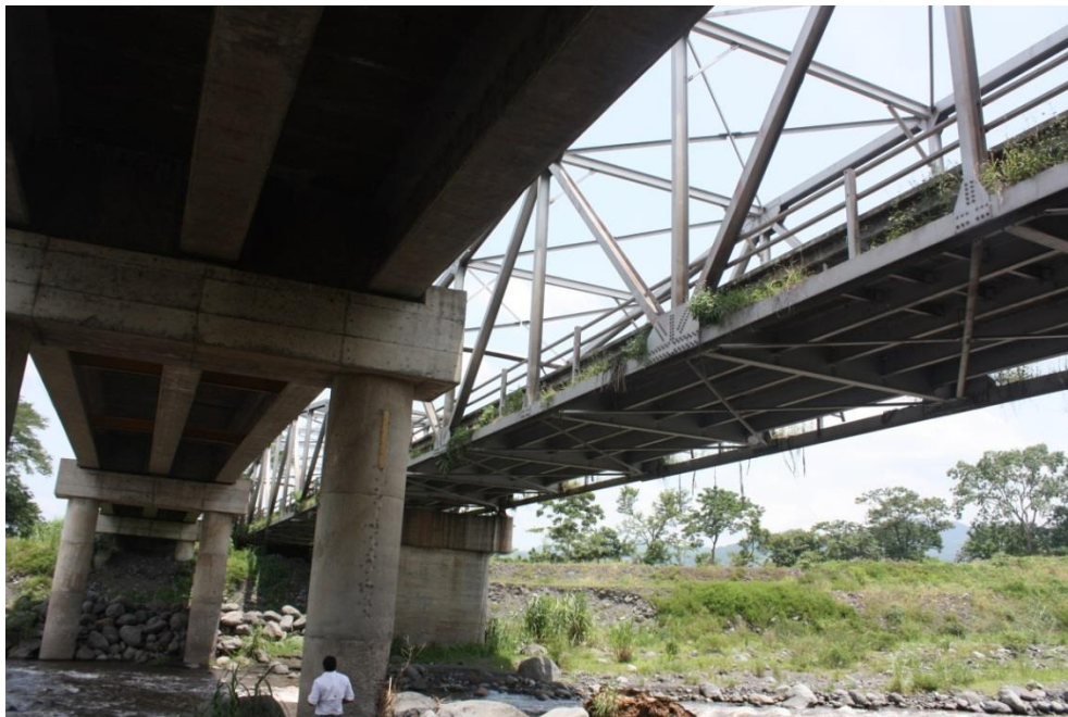
Figura No. 207. Vista de la superestructura de los puentes sobre el río Guacalate
