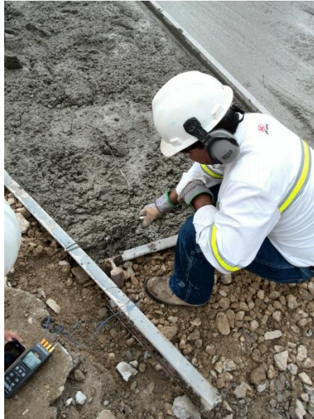
Figura No. 252. Colocación de termocuplas en campo.
