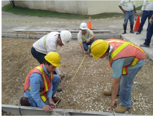
Figura No. 79 Colocación de sensores electrónicos.
