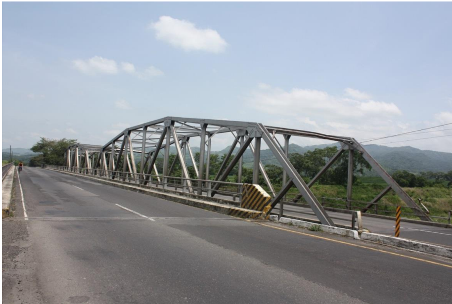
Figura No. 197. Vista superior de los puentes sobre el río Guacalate
