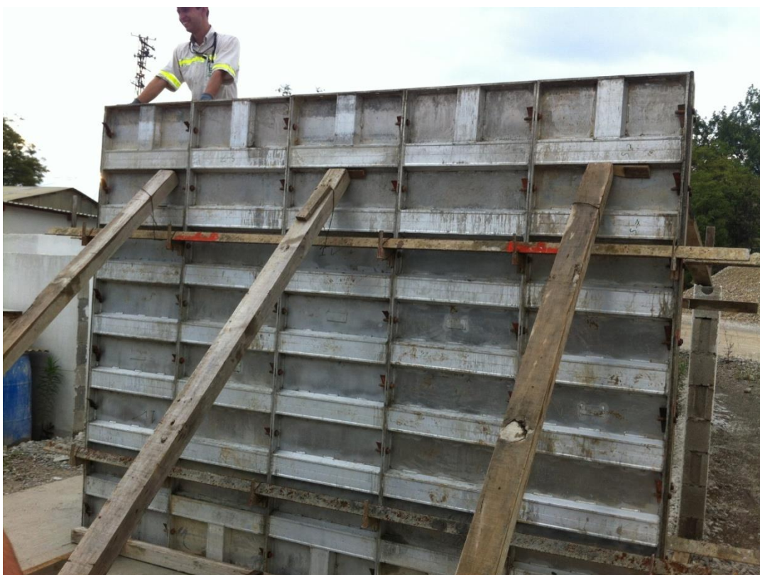
Figura No. 134 Muro fundido en planta de producción La Pedrera.
