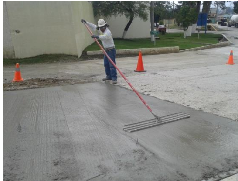
Figura No. 83 Acabados finales a la losa de concreto.
