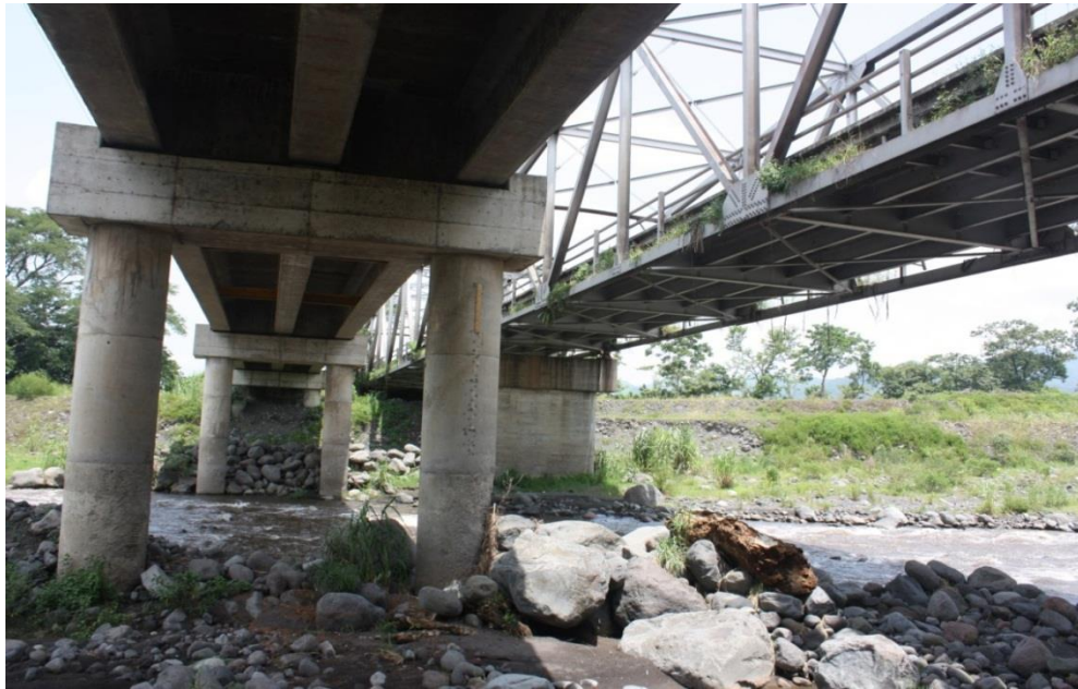
Figura No. 198. Vista inferior de los puentes sobre el río Guacalate
