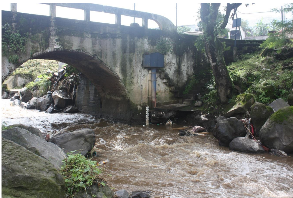
Figura No. 205. Vista del puente y antigua estación hidrológica del INSIVUMEH en Alotenango, Sacatepéquez
