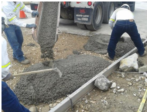
Figura No. 80 Fundición de la losa de pavimentación.
