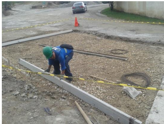
Figura No. 78 Colocación de secciones costaneras para delimitar geometría de losa.
