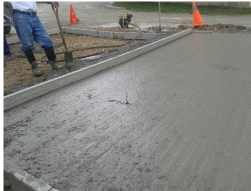
Figura No. 82 Nivelación de la losa de pavimentación.
