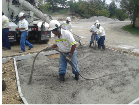
Figura No. 81 Vibración de concreto.
