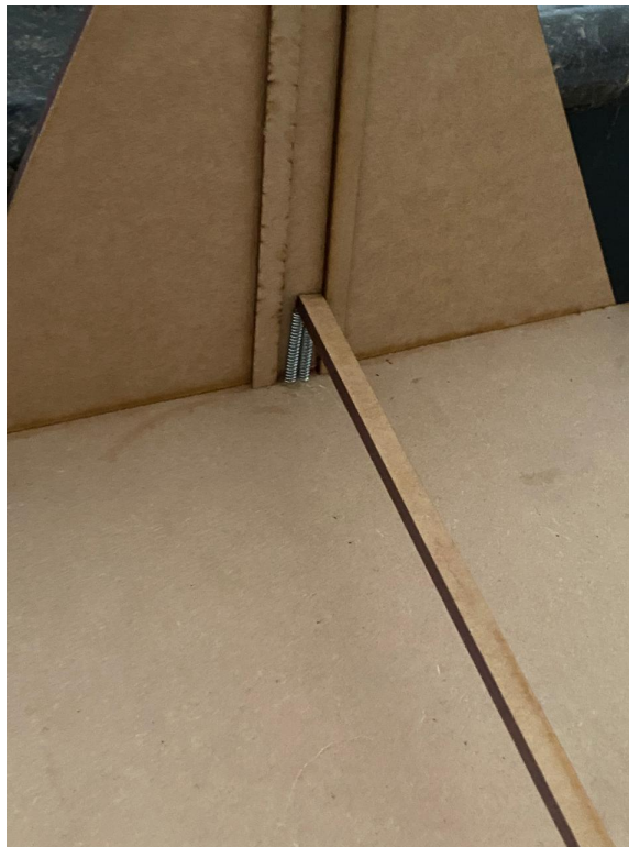
Figura 23: Colocación de resortes como medida de seguridad.
