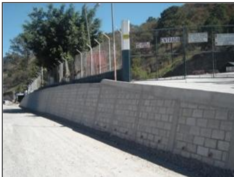
Fotografía No. 12 Construcción de muro perimetral (ZGAS).
