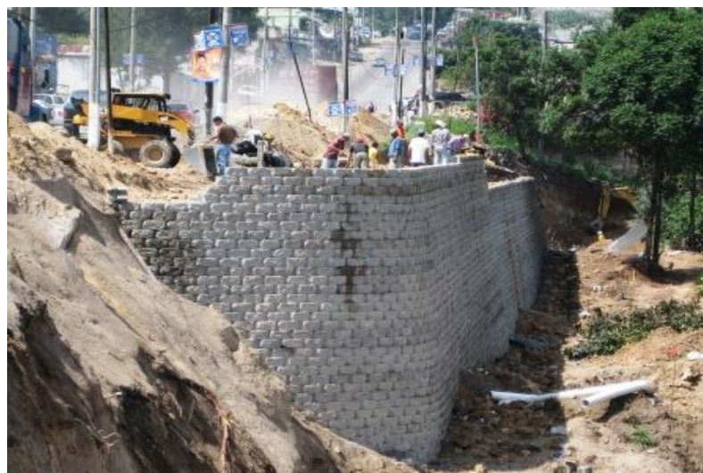
Fotografía No. 14 Construcción de Geomuros
