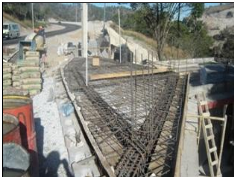
Fotografía No. 13 Construcción de losa de vivienda.
