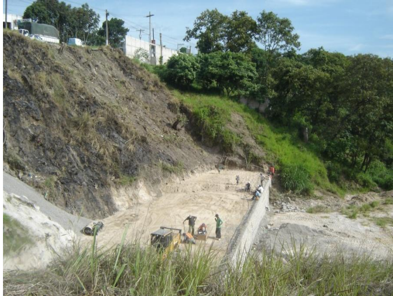
Fotografía No. 5 Construcción de Geomuros.
