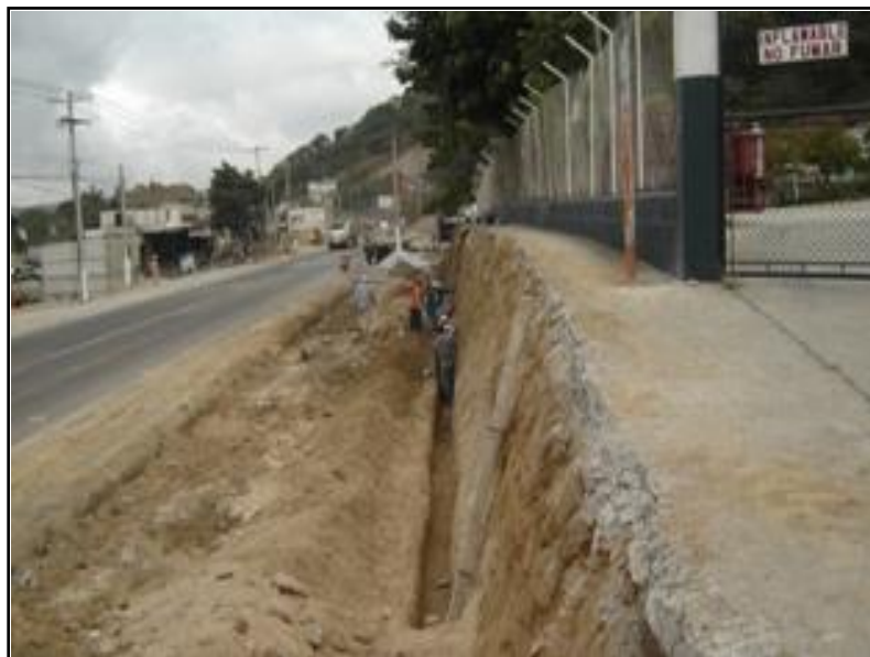
Fotografía No. 11 Construcción de muro perimetral (ZGAS).
