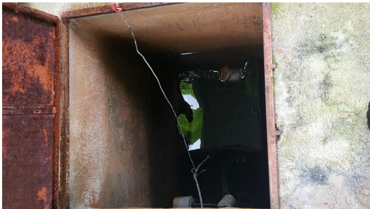
Anexo 1. Fotografía del interior de una de las dos cisternas utilizadas actualmente en el orfanato
