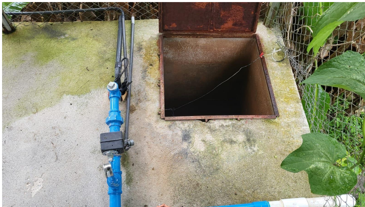
Anexo 2. Fotografía del interior de una de las dos cisternas utilizadas actualmente en el orfanato
