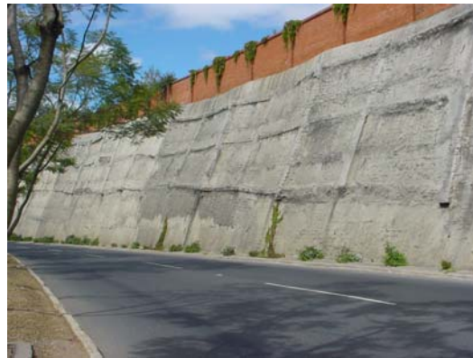
Figura 7: Muro de Retención con Malla
