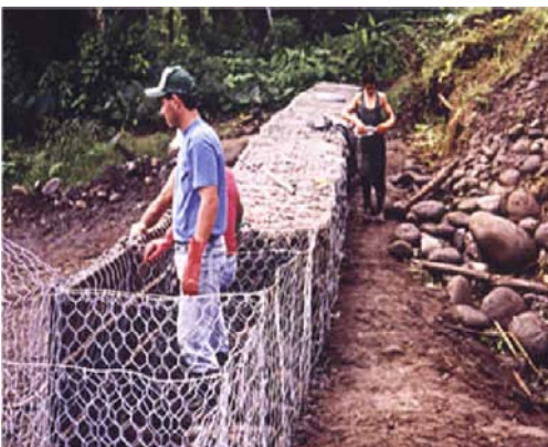
Figura 17: Mano de obra no especializada para el armado de los Gaviones
