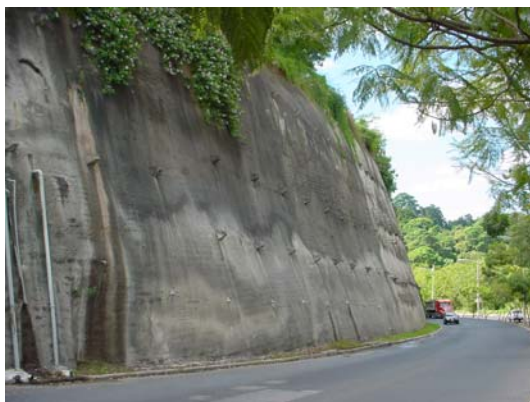
Figura 10: Muro de Retención con Anclaje Boulevard Landivar, Zona 15
