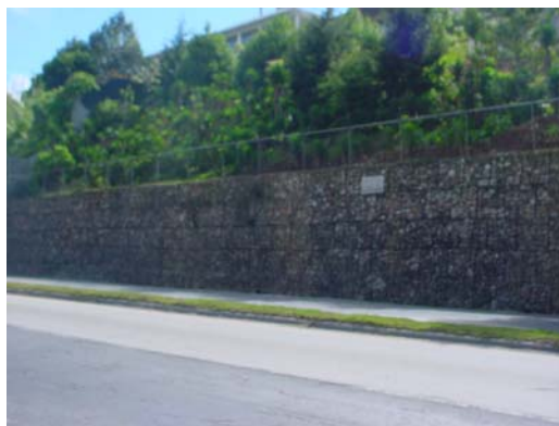
Figura 5: Muro de Retención con Gaviones Km. 10.5 Carretera al Salvador
