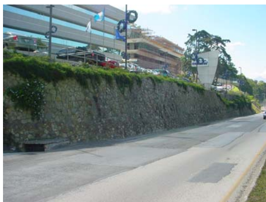
Figura 3: Muro de Retención de Concreto Ciclópeo Km. 8.7 Carretera al Salvador
