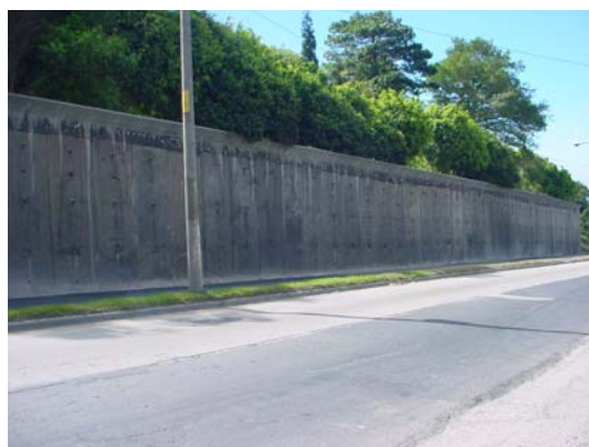
Figura 9: Muro de Retención con Anclaje Pre-Tensado Km. 10.5 Carretera al Salvador
