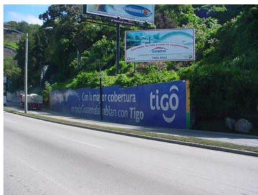
Figura 2: Muro de Retención de Concreto Armado (Voladizo) con Contrafuertes Km. 9.5 Carretera al Salvador
