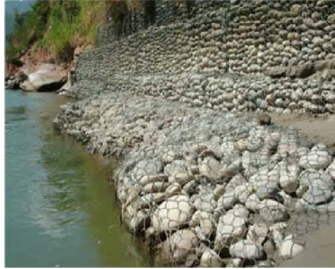
Figura 18: Gaviones a orillas de un río
