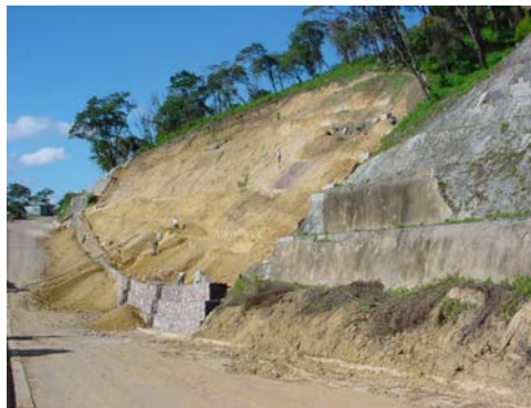
Figura 19: Construcción Muro de Gaviones Colonia Vistal Valle, Carretera al Salvador
