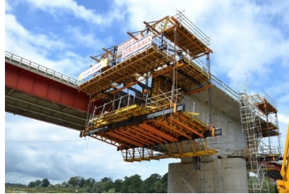
Figura 21: Construcción de dovela por voladizos sucesivos [27]
