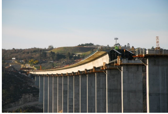
Figura 26: Puentes lanzados [12]
