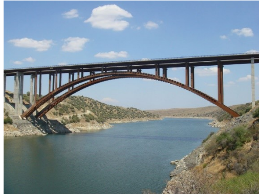
Figura 4: Puente tipo arco [10]
