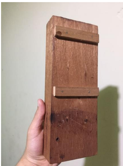
Figura No.65. Reglas de madera horizontales para la formación de acople entre tejas.
