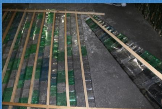
Colocación de todos los módulos en paralelo.
