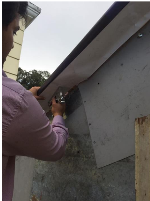
Figura No. 70. Sujeción de la manta vinílica lateralmente a la estructura
