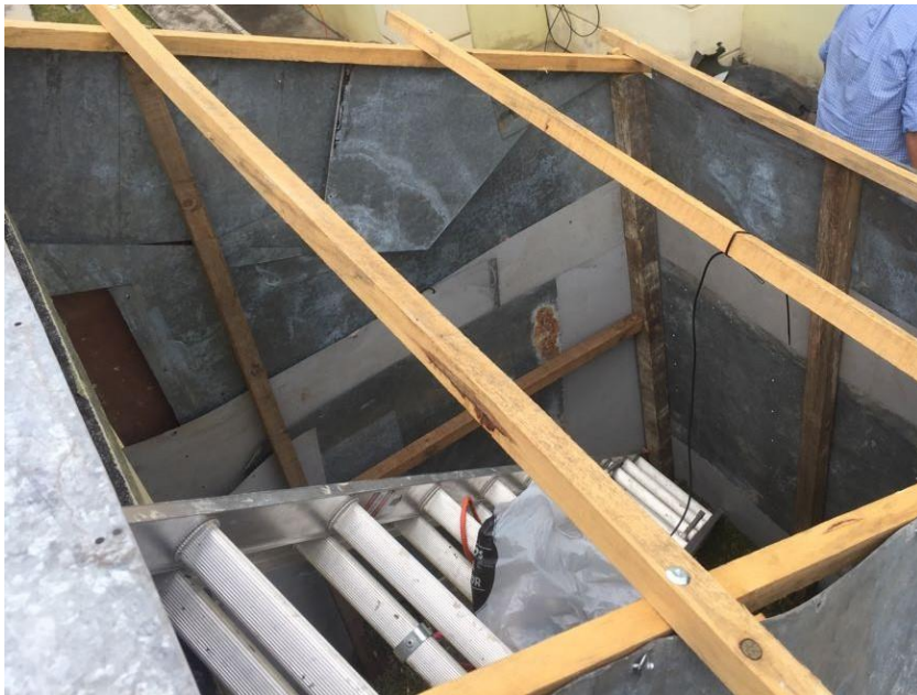
Figura No.66. Estructura de techado de caseta provisional
