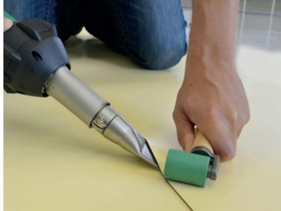
Figura No.9. Unión de mantas vinílicas
