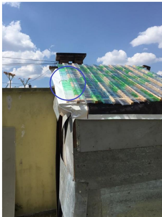
Figura No.87. Termocupla uno en el exterior del techado Ecolám
