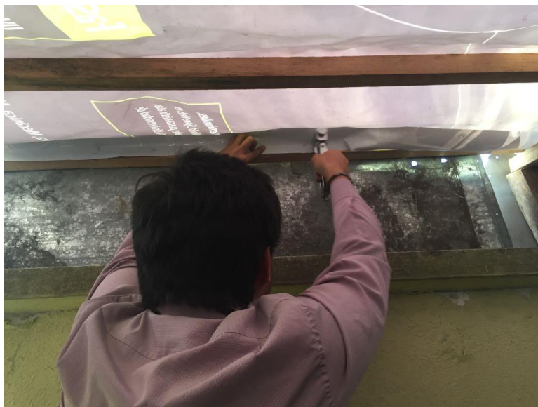
Figura No.68. Sujeción la manta vinílica a la estructura de techado
