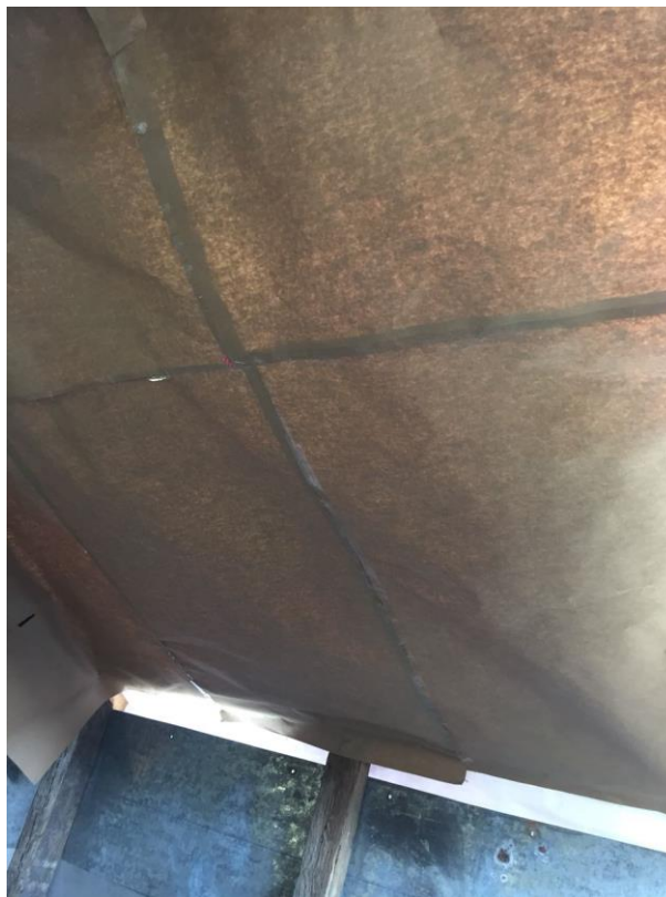
Figura No.82. Papel Kraft Instalado en el interior de la caseta
