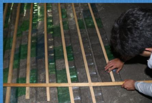
Colocación de vigas transversales por encima de todos los módulos.
