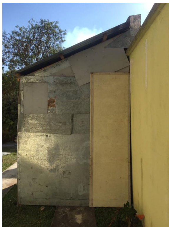
Figura No.78. Vista lateral derecha de la caseta.
