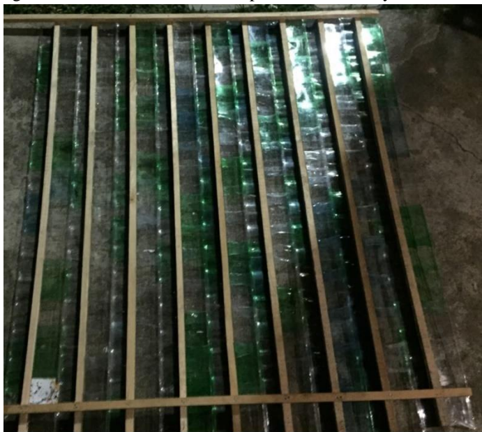
Figura No.27. Nueve módulos en paralelo tensados y ensamblados.
