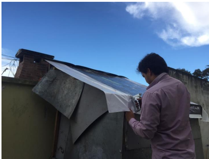
Figura No.69. Tensado de la manta vinílica a la estructura del techado.
