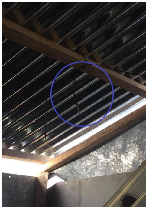
Figura No. 86 Termocupla dos en el interior de la caseta con techado de lámina galvanizada.
