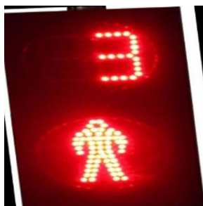
Figura 5.3: Semáforo peatonal en rojo.
