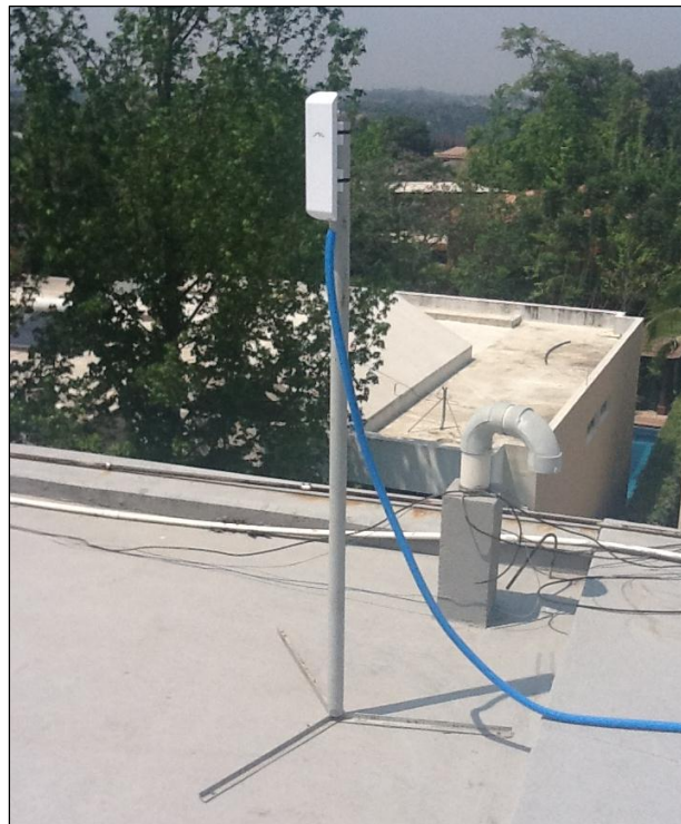
Figura 12. Montaje de antena NanoStation M5 en tubo metálico con base.
