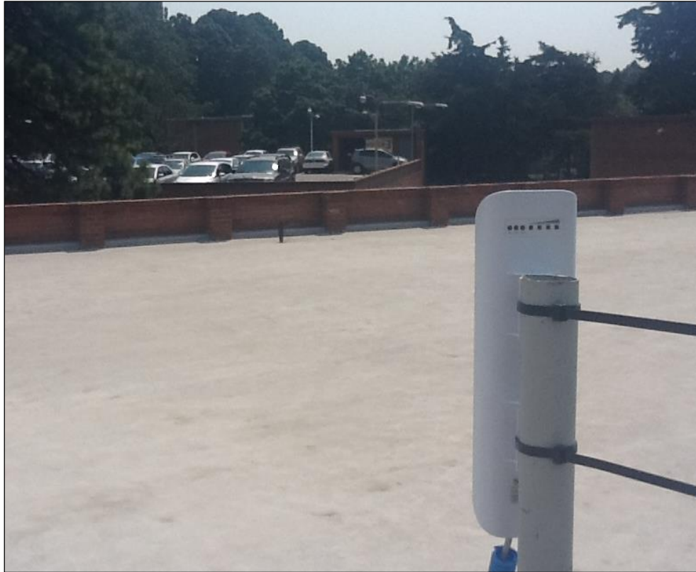
Figura 14. Vista del enlace desde el edificio J (Punto A).
