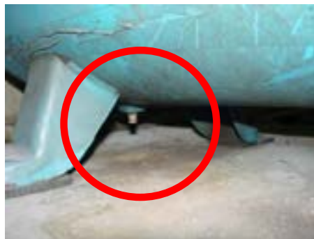
Figura 28: Válvula de purga del depósito de aire
