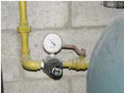
Figura 28: Válvula de purga del depósito de aire
