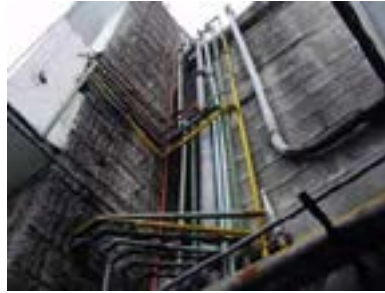
Figura 32: Distribución de tubería hacia puntos de uso
