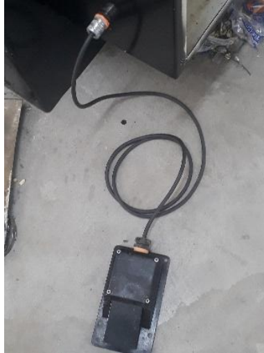
Figura 81: Instalación de pedal
