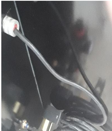
Figura 82: Instalación de cable de potencia
