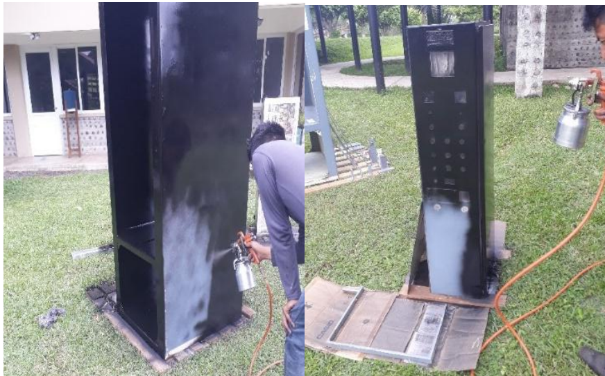
Figura 44: Aplicación de pintura
