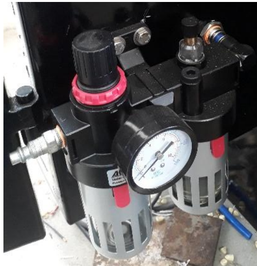
Figura 74: Instalación de unidad de mantenimiento
