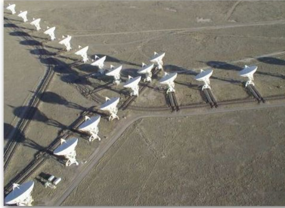
Figura IV.21: Arreglos de antenas para radio astronomía Very Large Array VLA que es un arreglo variable que consiste de 27 antenas.
