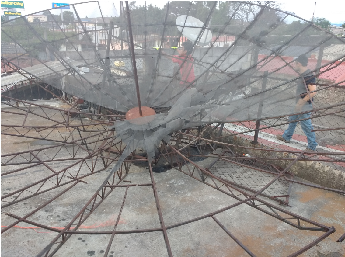
Figura XII.4: Deterioro de la antena recibida por donación.
