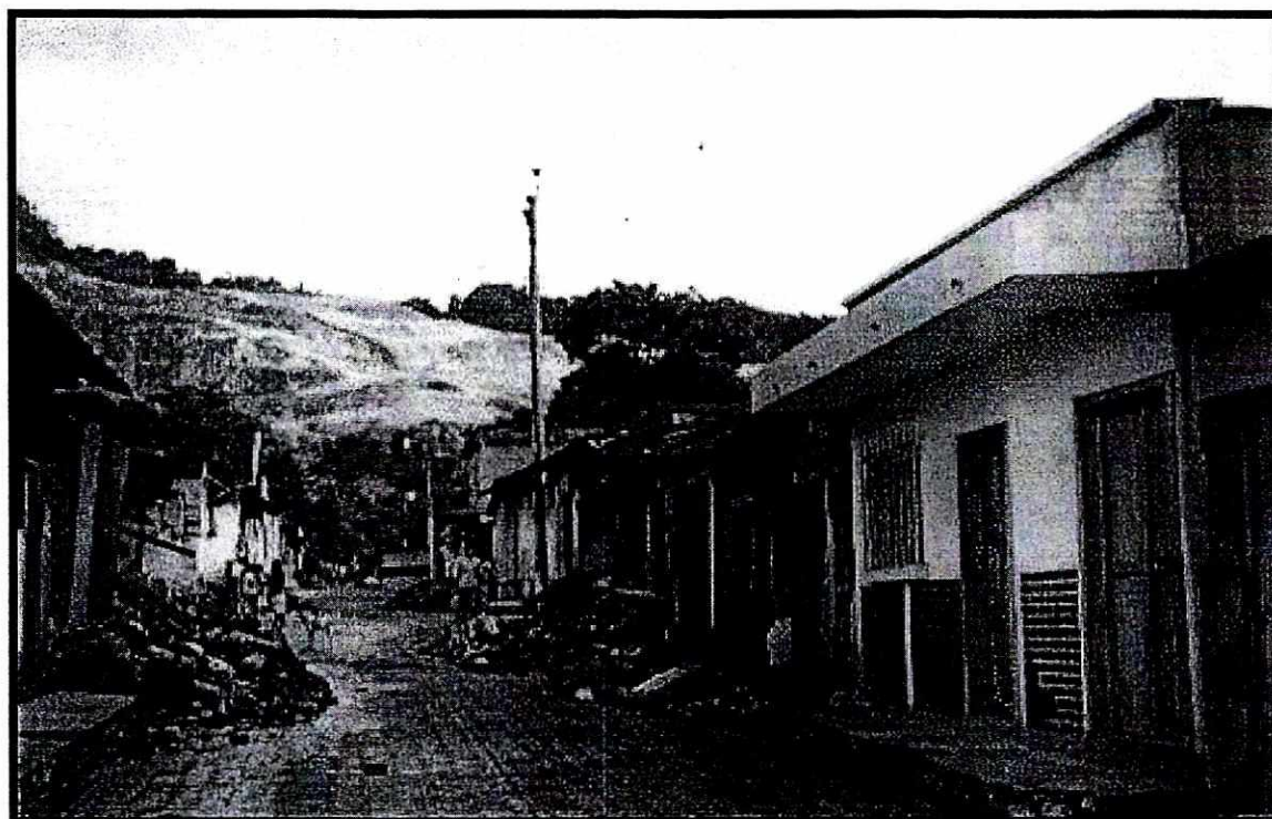
Notar que vivienda de mampostería no tiene daño, mientras hay viviendas de adobe colapsadas Pochuta, 1991 (Foto M. Matus).
