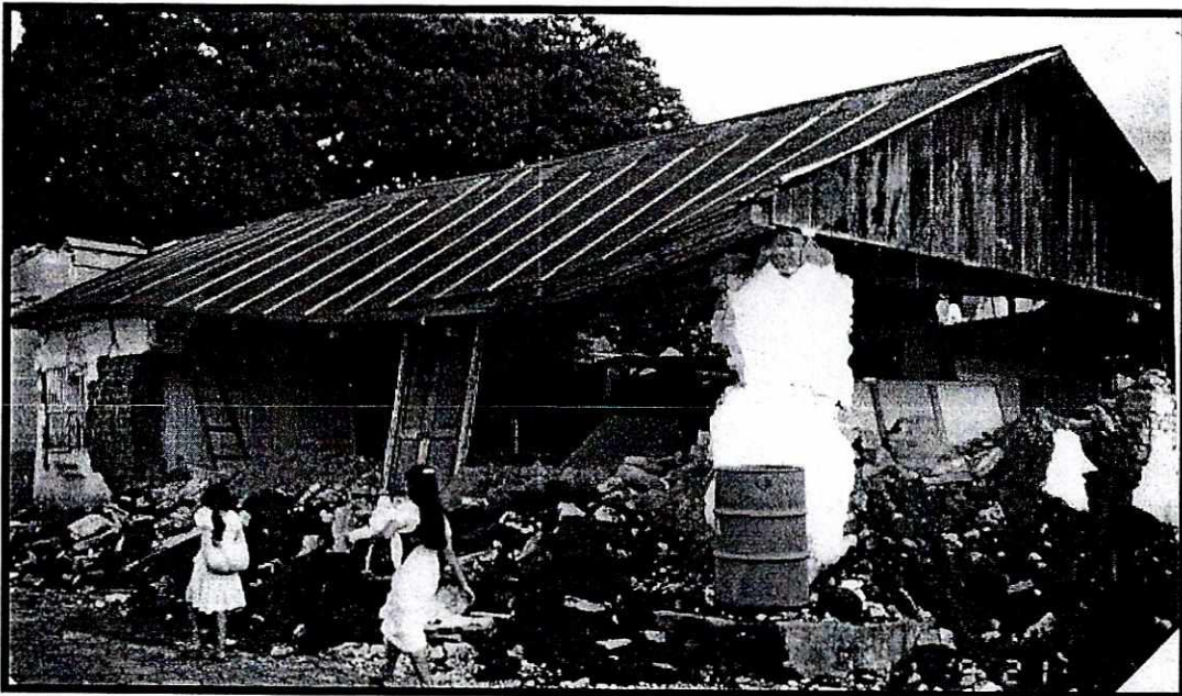
Casa de adobe colapsada totalmente, Pochuta, 1991 (Foto M. Matus)
