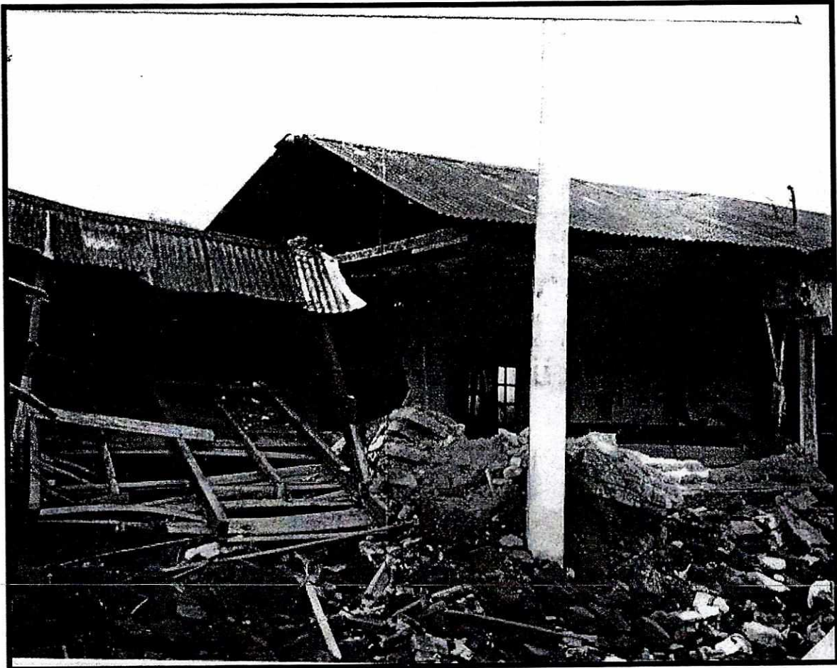
Vivienda de adobe colapsó totalmente, Pochuta, 1991 (Foto M.Matus).
