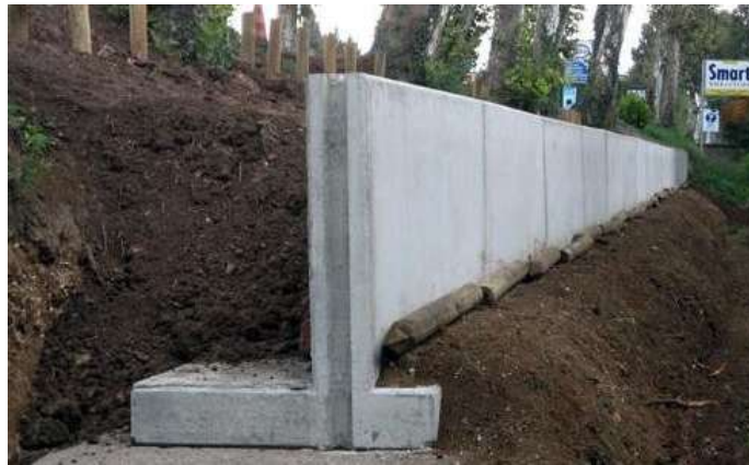
Figura 19. Muro de contención de concreto armado. (Fuente: Geotecnia y Mecánica de Suelos, 2023).
