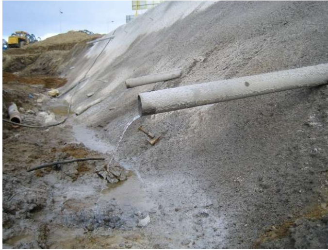
Figura 13. Drenes subhorizontales o californianos. (Fuente: Civogal, s.f.).
