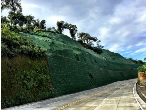
Figura 17. Muro recubierto con geotextil. (Fuente: ItalPlast, s.f.)
