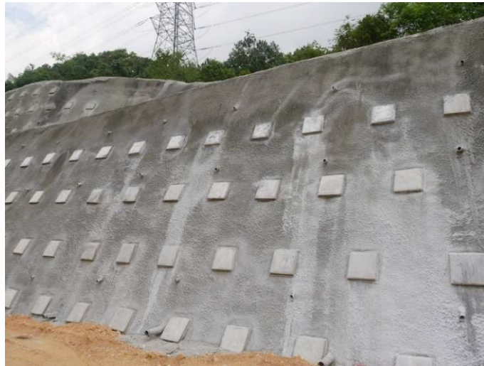
Figura 16. Muro de soil nailing recubierto con shotcrete (concreto lanzado). (Fuente: UMA Geotechnical Construction).
