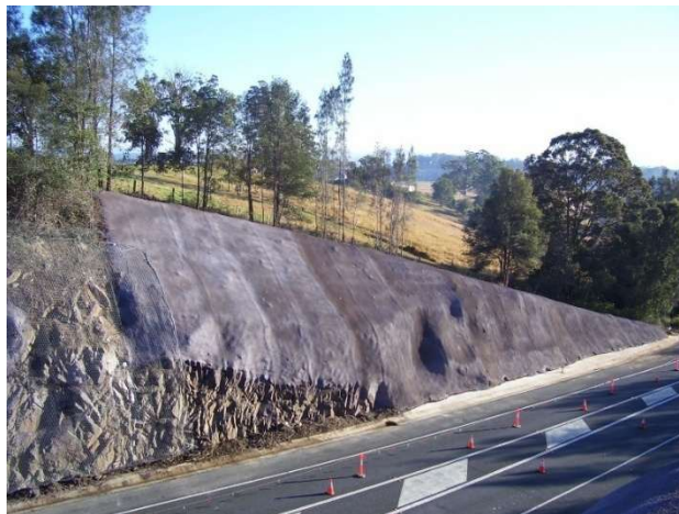
Figura 18. Muro recubierto con concreto lanzado. (Fuente: Geotechnical Engineering, Australia, s.f.)
