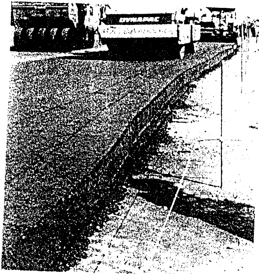
RASPADO VERTICAL DE JUNTAS CON CUCHILLA
